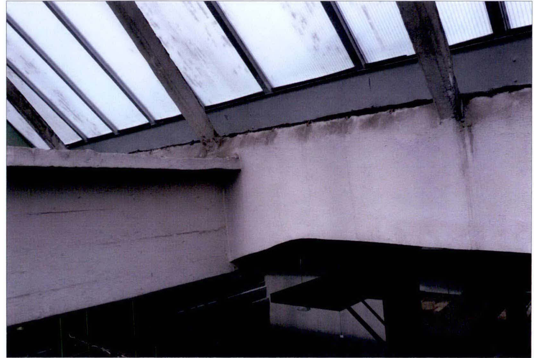
Świetlik pierwszy od strony zachodniej. Widoczne pozostałości (ucięte profile stalowe) pierwotnego szkieletu dla szyb świetlika.
