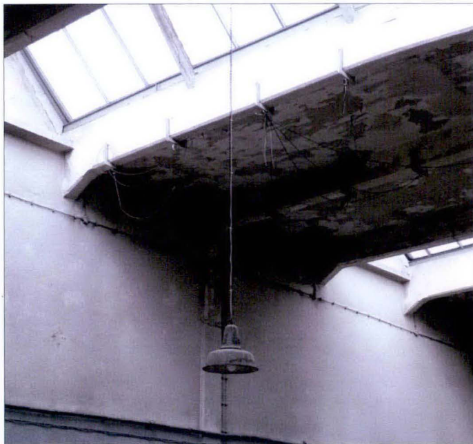
Żebra poprzeczne płyty stropowej przy ścianie północnej, dzielącej budynek.
