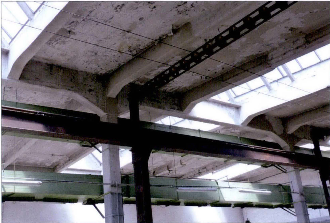
Konstrukcja wsporcza płyty stropowej z słupami żelbetowymi w osi podłużnej hali.
