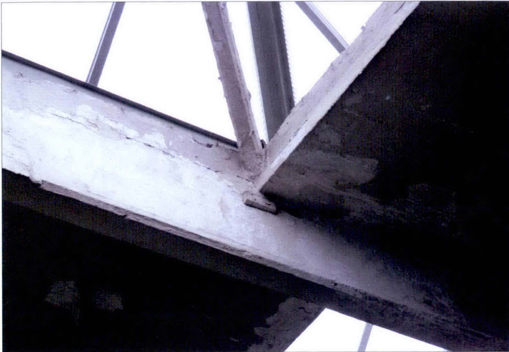
Świetlik drugi od strony zachodniej, widoczny pozostawiony element drewniany pochodzący prawdopodobnie z konstrukcji szalunkowej użytej podczas wznoszenia hali.
