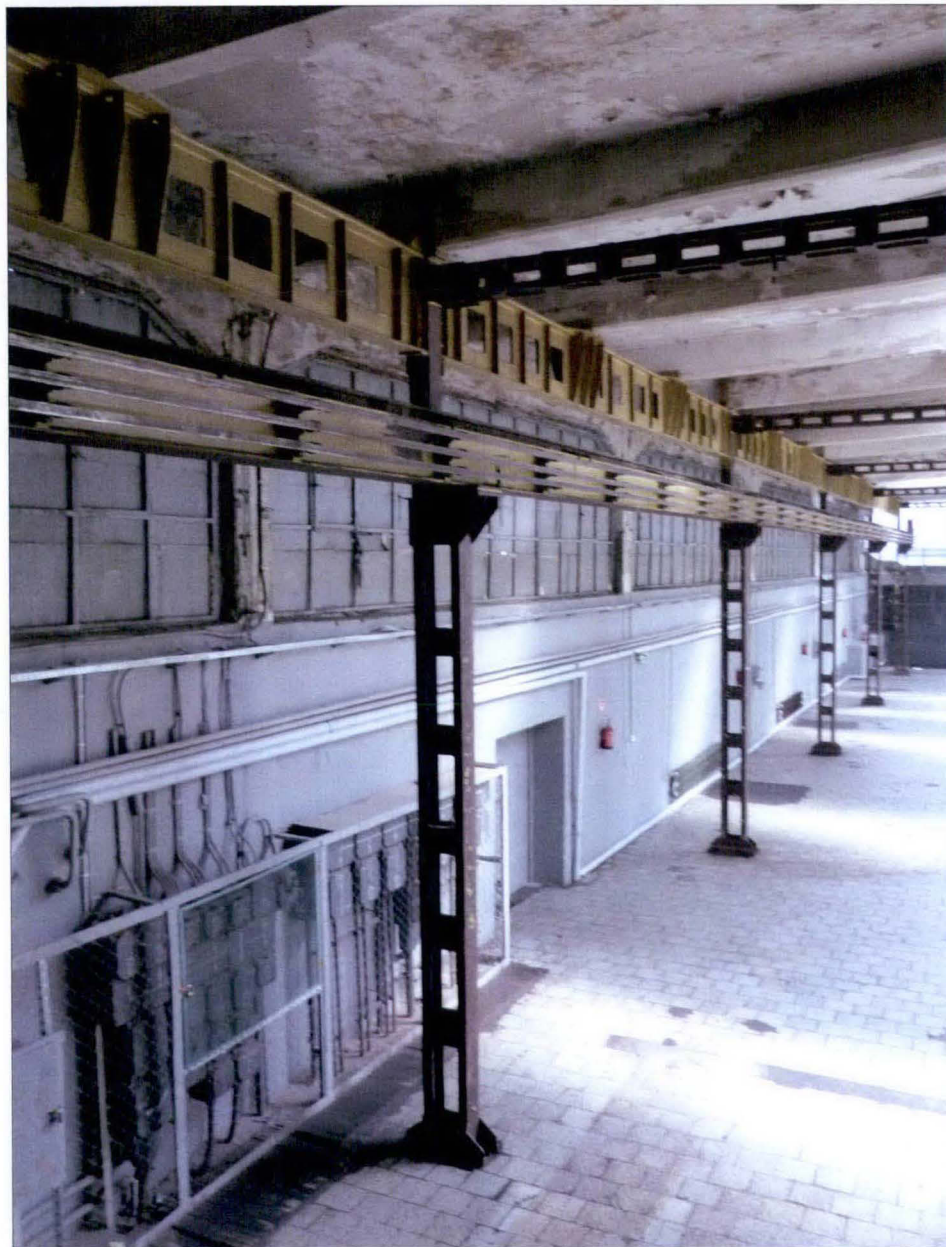
Południowa ściana hali, konstrukcja mostu suwnicy z szynoprzewodem zasilającym.
