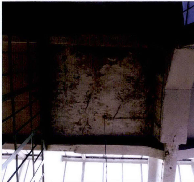
Strop nad korytarzem w części zachodniej. Widoczne pogrubione żebra i podciąg w miejscach naprawy i wzmocnień po uszkodzeniach z okresu II wojny światowej.
