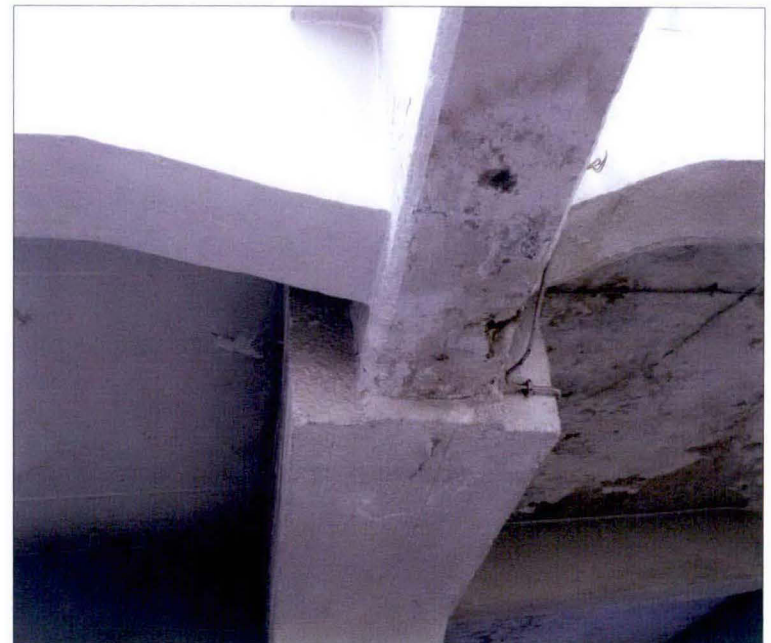
Podciąg i poprzeczne żebra ze skosami, widoczny fragment podciągu wzmocniony obudową betonową.
