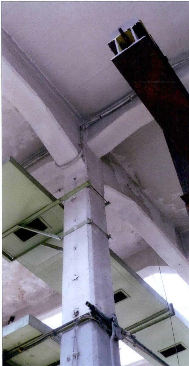
Słup żelbetowy wspierający podciąg i żebra poprzeczne.
