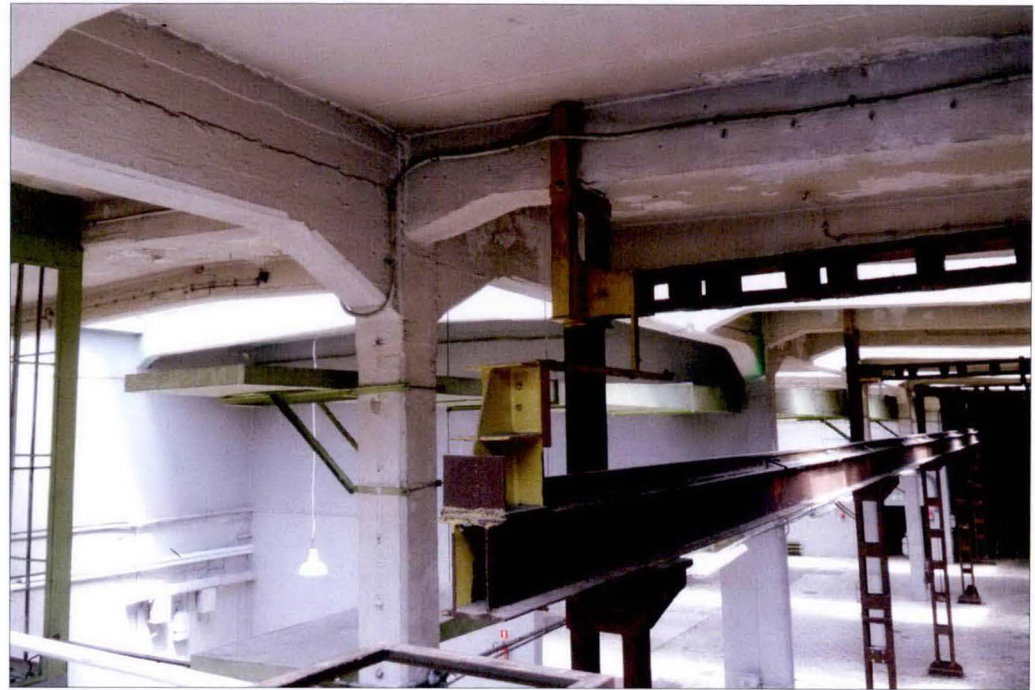
Słup na osi podłużnej hali, widoczny podciąg i żebra poprzeczne ze skosami oraz dodatkowe wsparcia żeber na podwyższonych stalowych słupach suwnicy.
