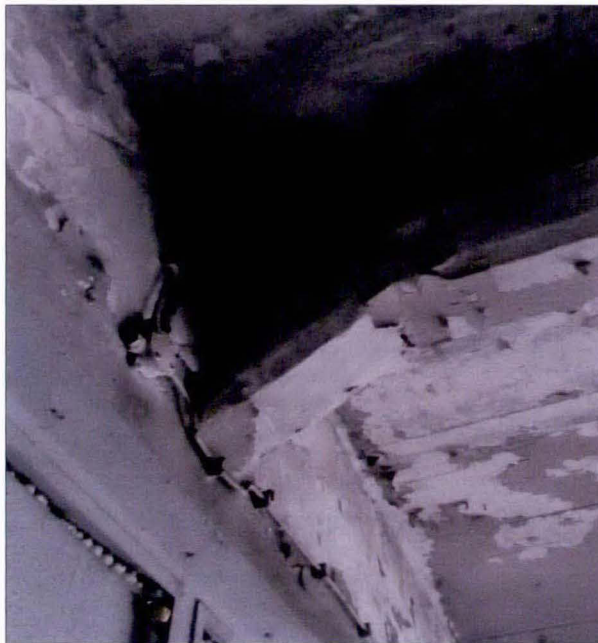
Żebro ze skosem, oparte na podciągu w południowej ścianie budynku.
