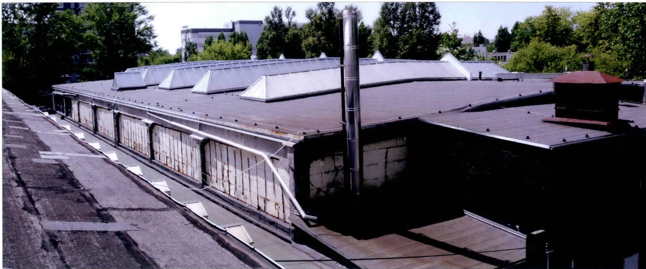
Elewacja południowa ponad parterowym łącznikiem z sąsiadującą halą oraz przybudówką od strony wschodniej. Widoczna prowizoryczna termoizolacja w segmentach okien doświetlających.
