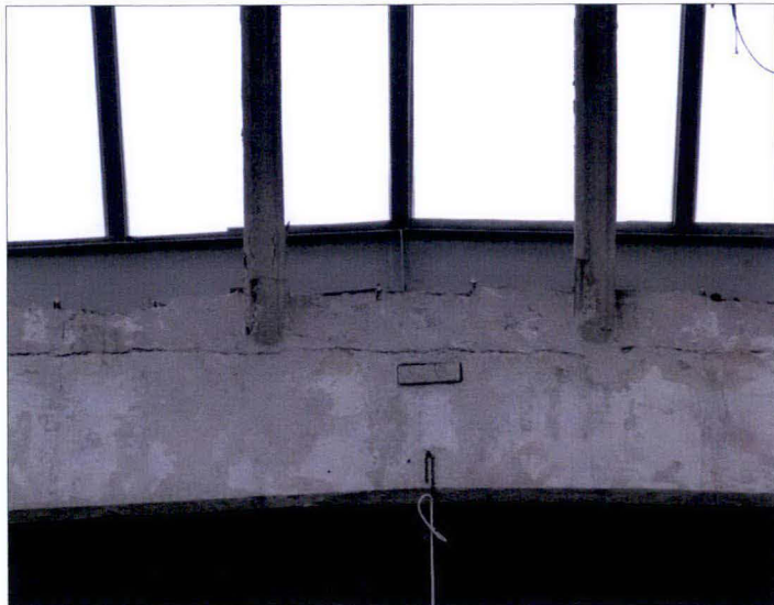
Szczytowy fragment świetlika, widoczne pierwotne, żelbetowe belki wsporcze świetlika.
