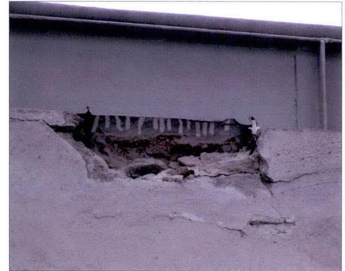
Uszkodzenia stropu żelbetowego i pierwotnej obróbki blacharskiej w sąsiedztwie wtrórnjej konstrukcji świetlika.
