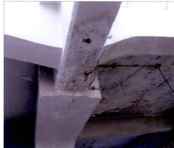
Strop nad korytarzem w części zachodniej. Widoczne pogrubione żebra i podciąg w miejscach naprawy i wzmocnień po uszkodzeniach z okresu II wojny światowej.
