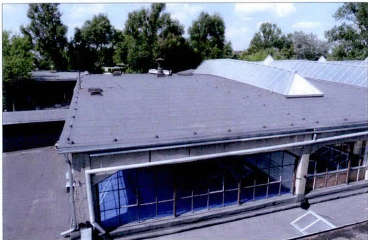
Elewacja południowa ponad parterowym łącznikiem z halą sąsiednią. Widoczny dach hali z wtórnymi świetlikami oraz pokryciem dachowym i instalacją odprowadzającą wodę opadową po kompleksowej modernizacji w latach 2011–2013.
