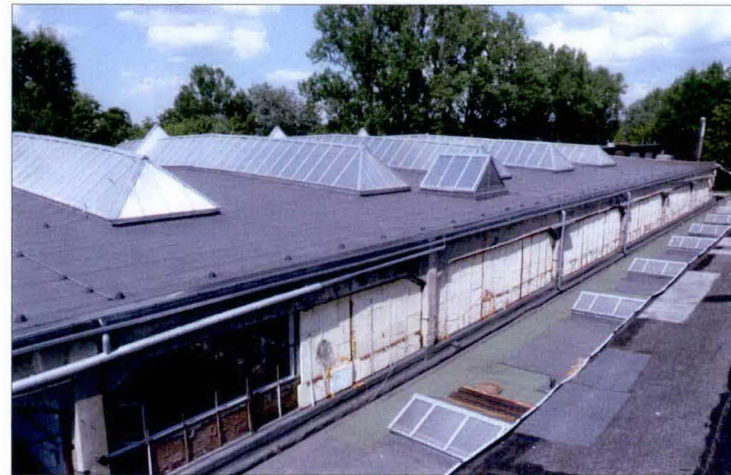
Elewacja południowa ponad parterowym łącznikiem z halą sąsiednią. Widoczny dach hali z wtórnymi świetlikami oraz pokryciem dachowym i instalacją odprowadzającą wodę opadową po kompleksowej modernizacji w latach 2011–2013.
