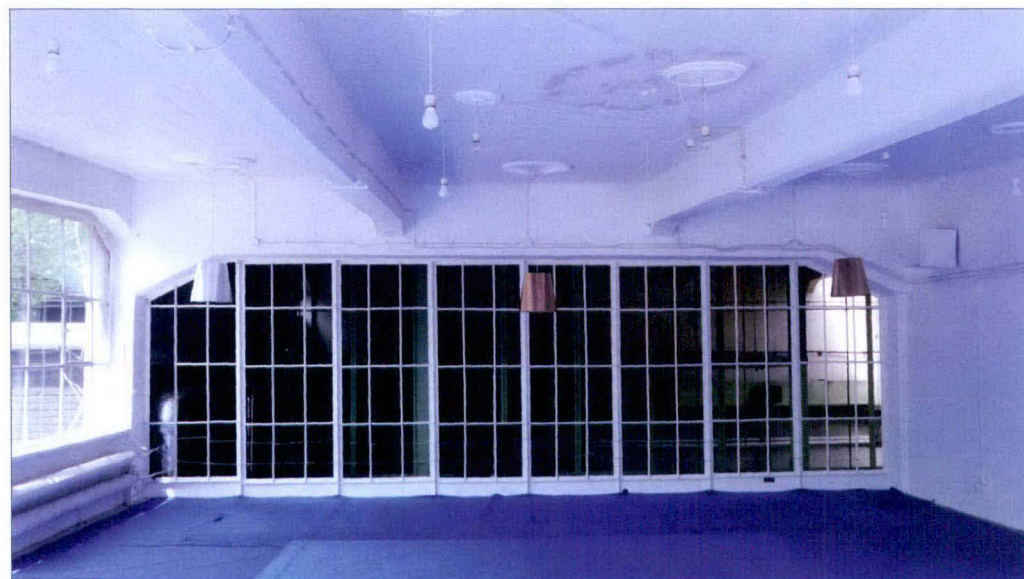
Antresola w części południowo-zachodniej hali. Widok na ścianę wykonaną ze stalowych ramiaków, obecnie pozbawionych szklenia.
