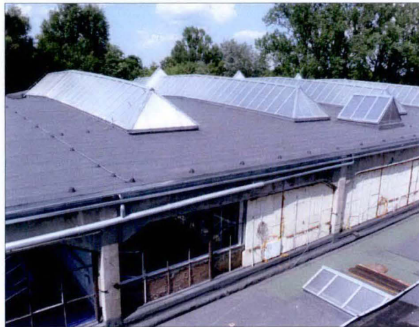
Elewacja południowa ponad parterowym łącznikiem z halą sąsiednią. Widoczny dach hali z wtórnymi świetlikami oraz pokryciem dachowym i instalacją odprowadzającą wodę opadową po kompleksowej modernizacji w latach 2011–2013.
