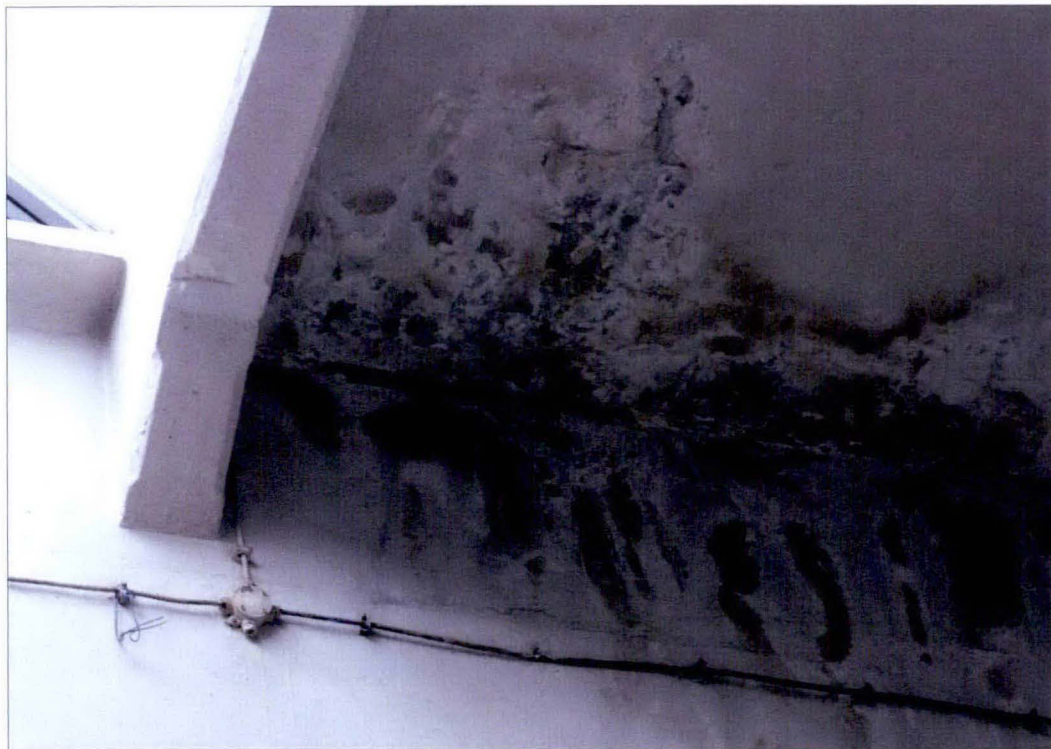
Strop przy podciągu w środkowej części hali. Widoczne oryginalne fazowanie krawędzi żelbetowego dźwigara oraz uszkodzenia spowodowane zawilgoceniem stropu i ściany.
