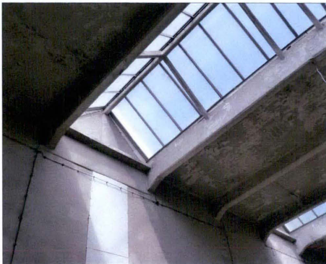
Świetliki w stropie hali, widoki ogólne konstrukcji wsporczej dachu.
