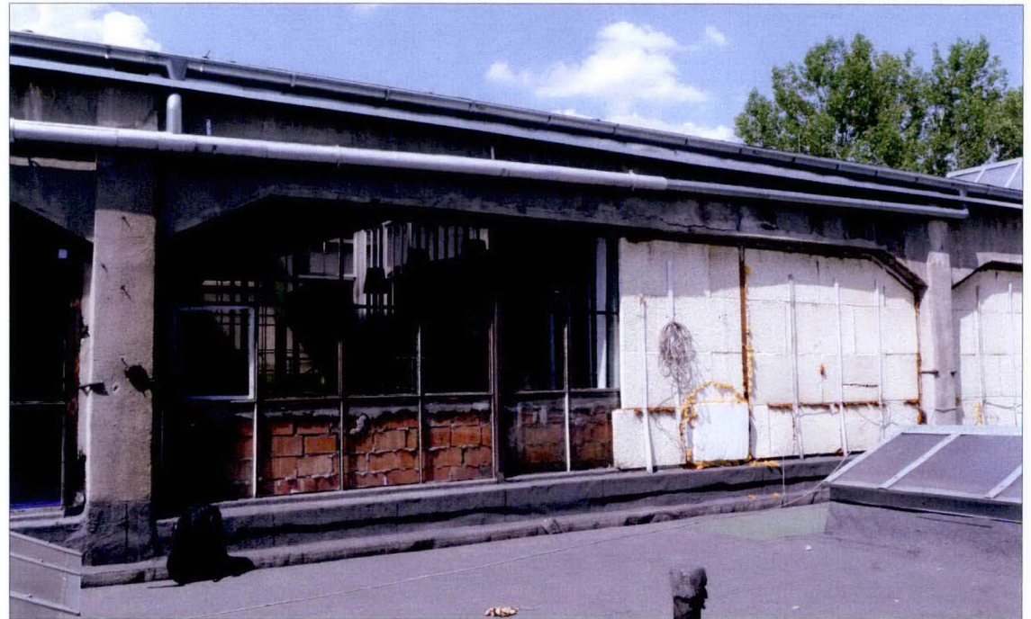
Elewacja południowa (II segment od strony zachodniej). Widoczne wtórne wymurowania wewnętrzne oraz prowizoryczna termoizolacja z płyt styropianowych.
