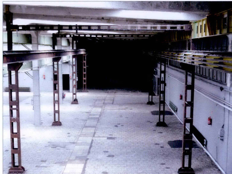
Wnętrze hali, widok w kierunku wschodnim. Widoczna konstrukcja jezdna suwnicy.
