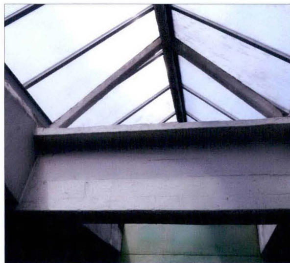
Żelbetowy podciąg nośny stropu w obrębie świetlika.
