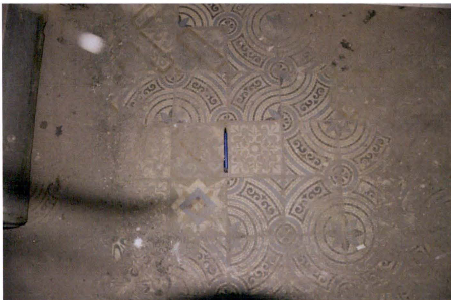
53 Posadzka w piwnicy lokalu użytkowego w kamienicy – ceramika z różnych okresów, w lewym górnym rogu widoczna np. szaro-żółta ceramika użyta do wyłożenia podestu I piętra kamienicy
