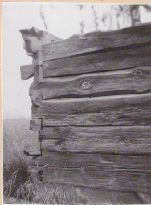
7. Narożnik pld.-zach. zniszczonej stodoły. Połączenie bali w węgle.
