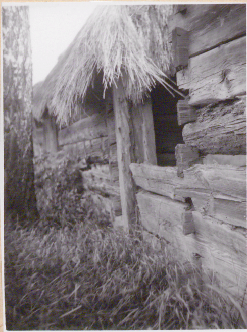
14. Połączenie bali stodoły zniszczonej ze słupem przylegającym do ściany frontowej stodoły użytkowanej obecnie.
