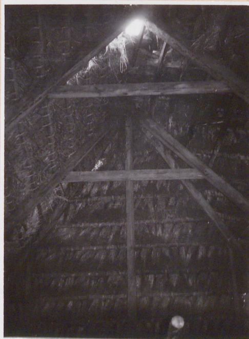
12. 1 Konstrukcja dachu stodoły.
