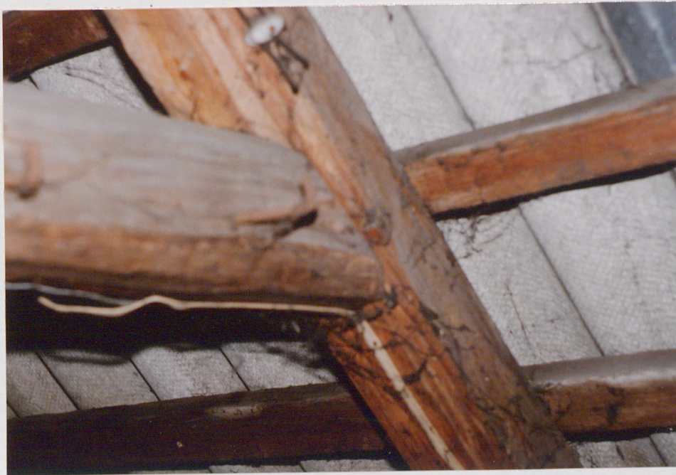
Konstrukcja drewniana więźby dachowej - łączenie elementów na kolki drewniane
