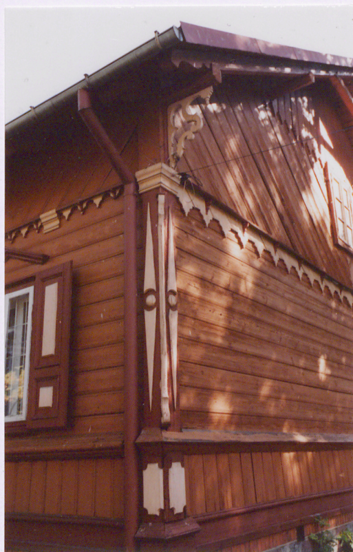
10. Szalowanie narożnika oraz ścian budynku.
