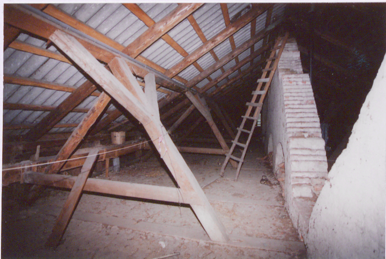
19. Konstrukcja więźby dachowej.
