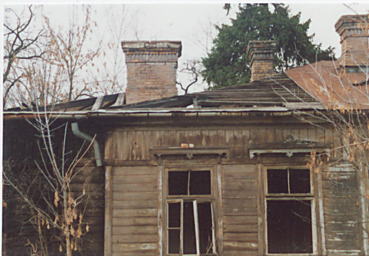
12. Część zachodnia budynku z nadpaloną więźbą dachową
