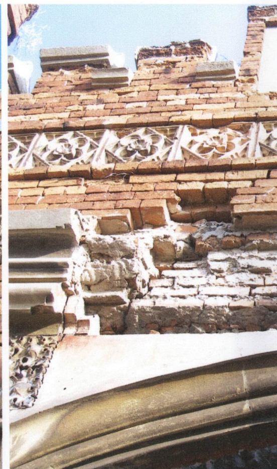
Brama – ubytki cegły w szczycie
