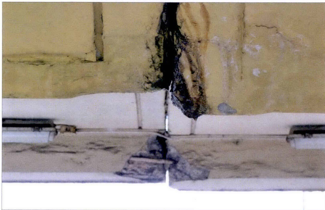
Korozja konstrukcji łupiny wiaty.
