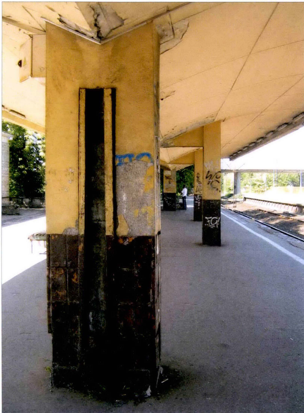
Korozja betonu filaru wiaty na peronie 1. Widoczna charakterystyczna rura spustowa.
