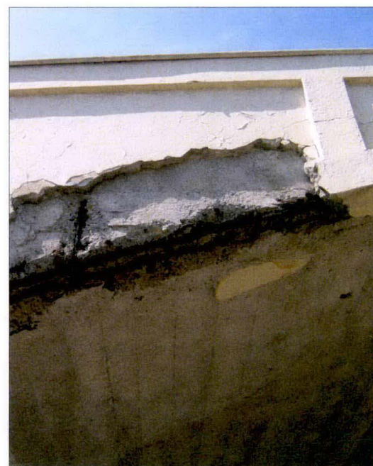
Korozja betonu konstrukcji dachu.
