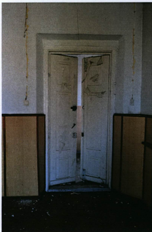
Zachowane ramowo-płycinowe drzwi wewnętrzne
