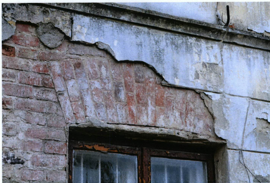
Odsłonięte nadproże okienne w elewacji południowej
