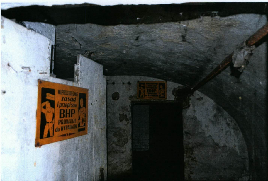
Sklepienie kolebkowe w piwnicy
