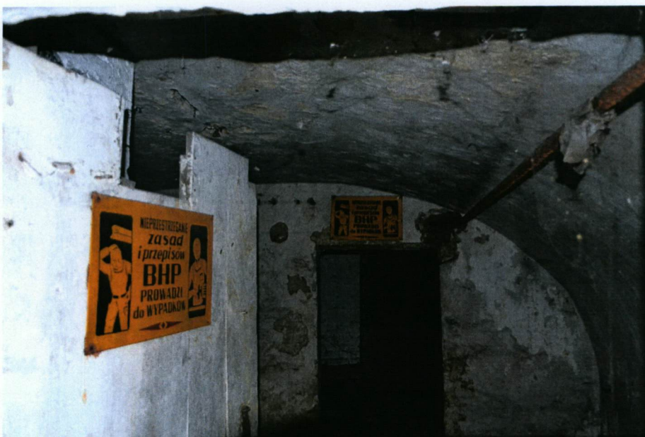
Sklepienie kolebkowe w piwnicy
