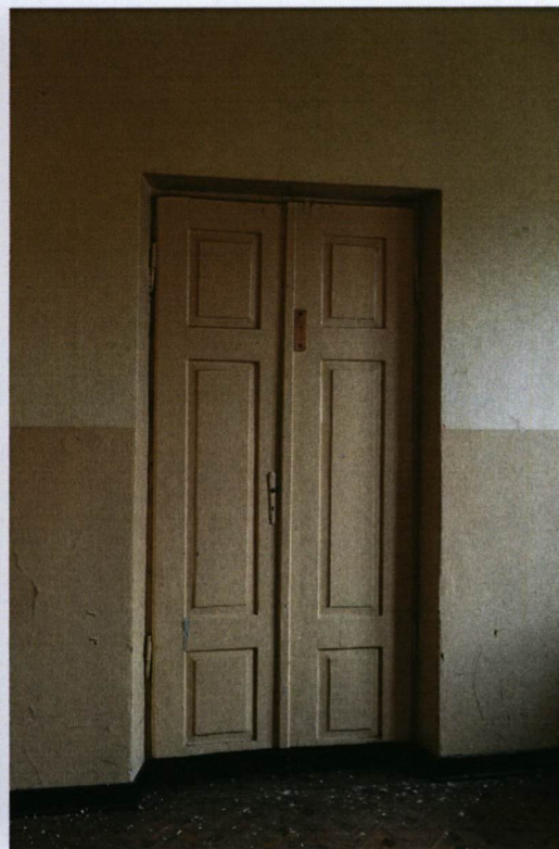
Zachowane ramowo-płycinowe drzwi wewnętrzne
