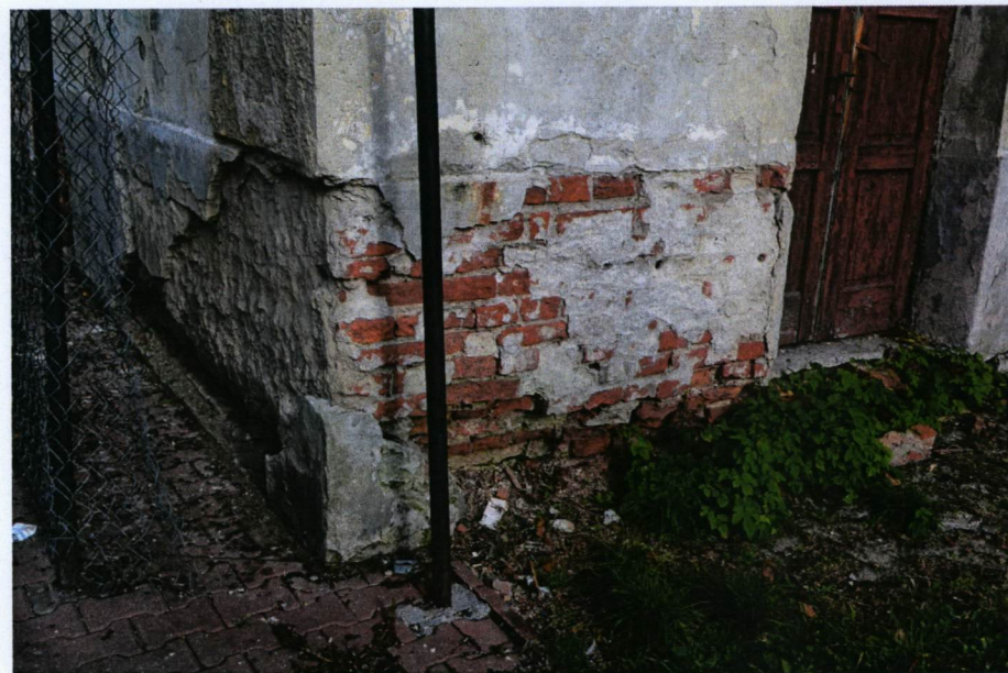
Zawilgocenia i ubytki tynku przyziemia
