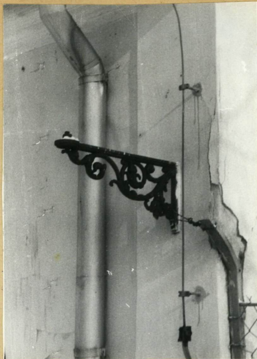
fot.8 El. zachodnia - żeliwny wspornik.
