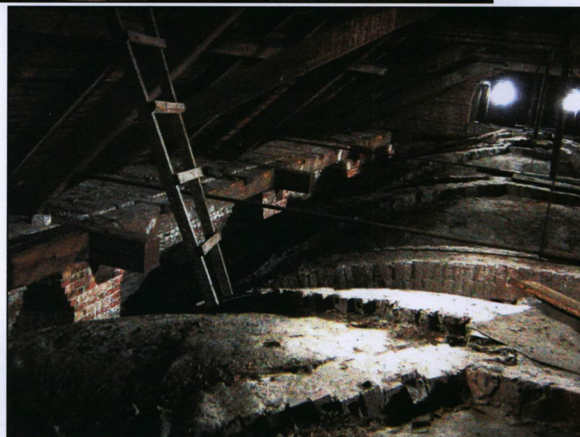
Sklepienie korpusu i korona północnej ściany
