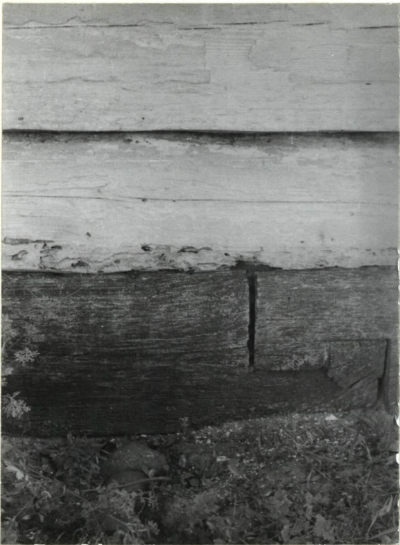
sposób łączenia podwaliny
