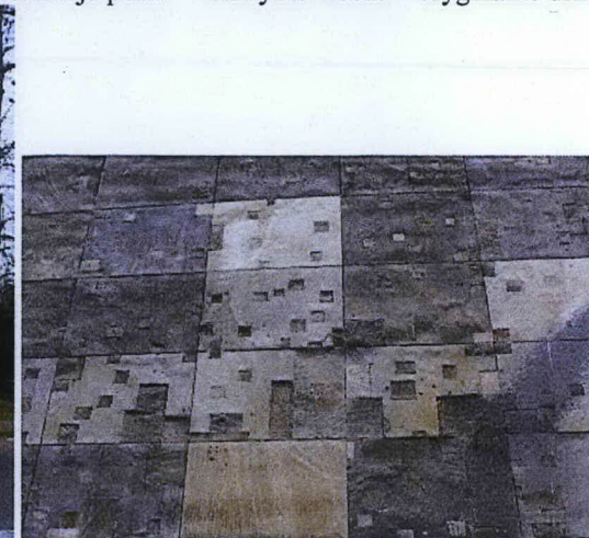
okładzina z piaskowca – detal
