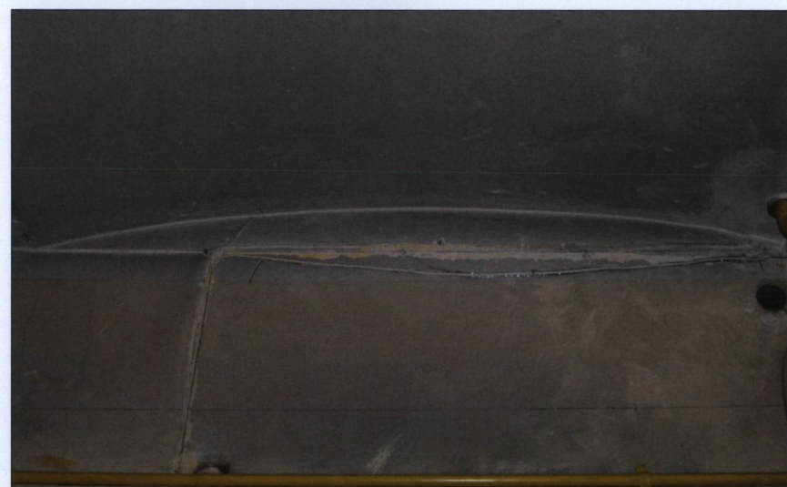
Klatka schodowa – płyta podestu w technice stropu odcinkowego (od dołu).
