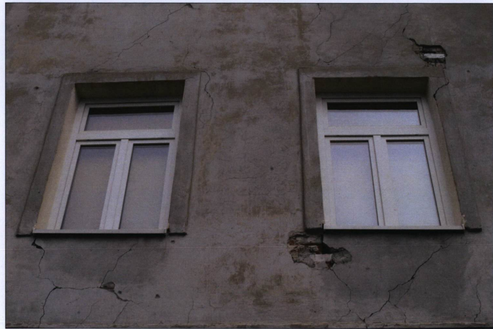
Elewacja tylna – spękania strukturalne murów; widoczne opaskowe obramienia okien.
