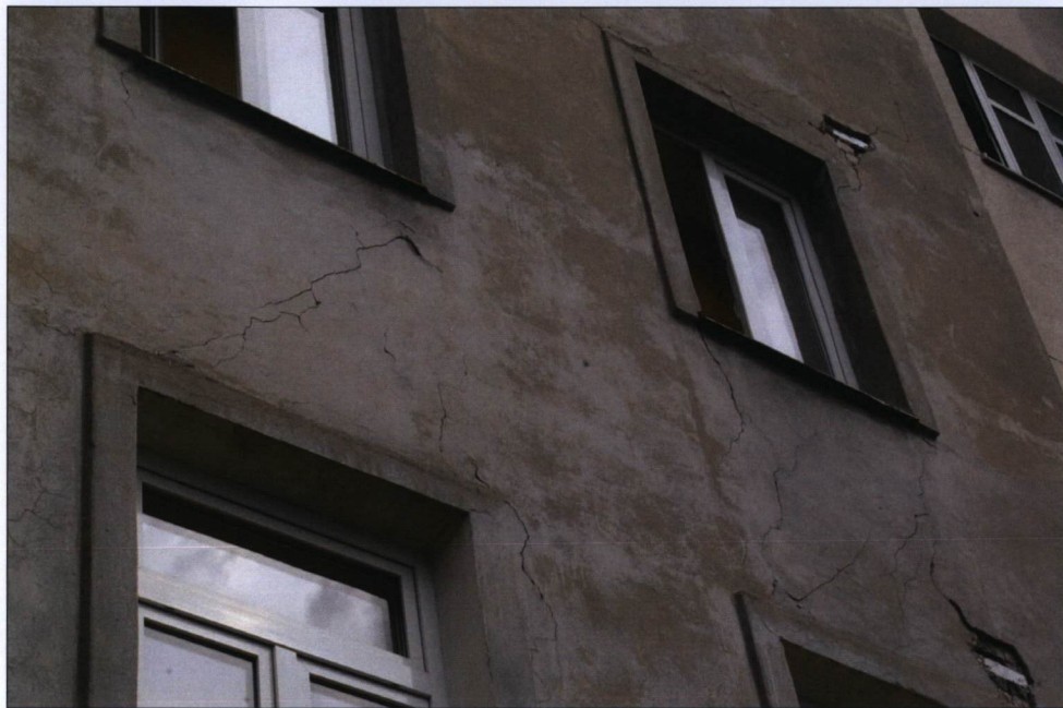
Elewacja tylna – spękania strukturalne murów; widoczne „szkiełka” pomiarowe.
