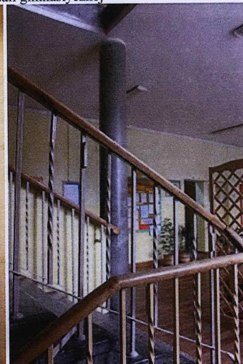
słup podpierający strop przy klatce schodowej
