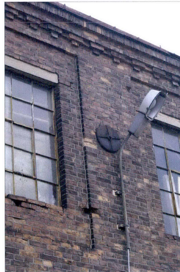
Galwanizernia – detal architektoniczny elewacji; widoczny gzyms z pseudokroksztynami; stan na 2006 r.
