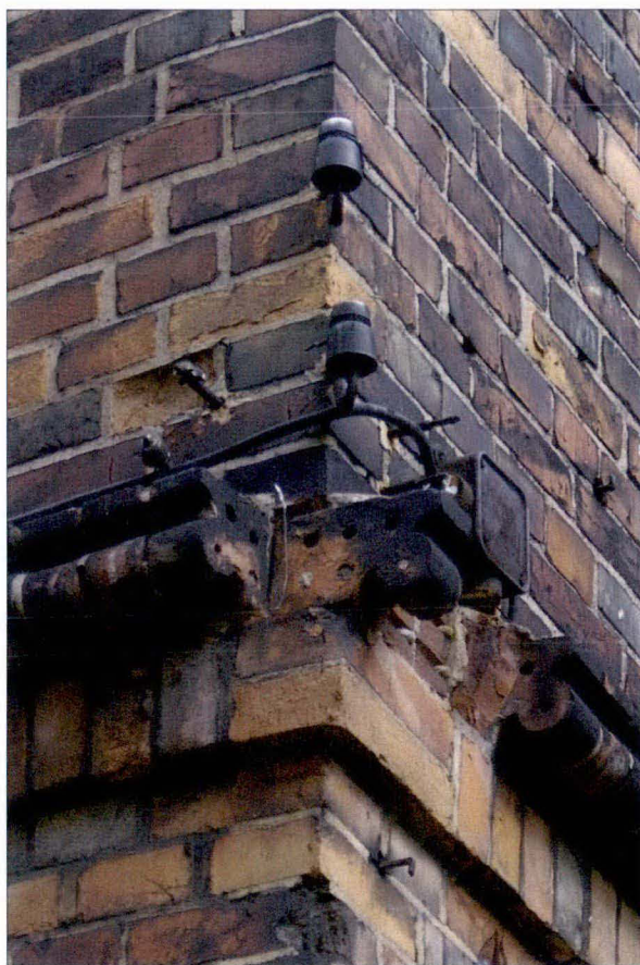
Budynek biurowy – gzyms kordonowy z profilowanych elementów ceramicznych; stan na 2006 r.
