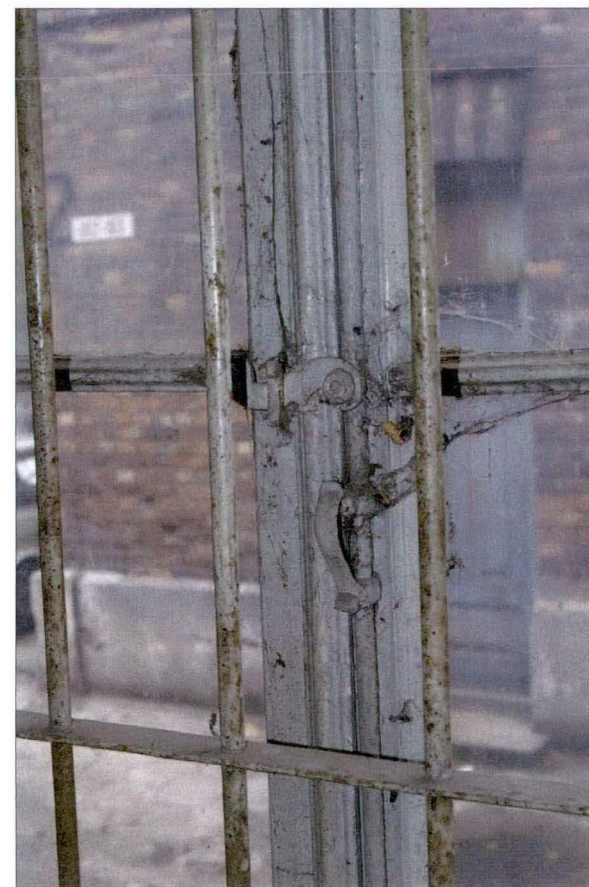
Budynek biurowy – konstrukcja i stan zachowania stolarki okiennej z zawrotnicami; stan na 2006 r.
