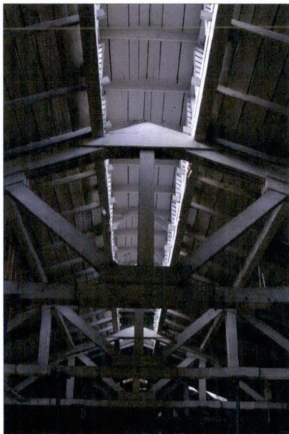
Hala główna – konstrukcja dachu; stan na 2006 r.
