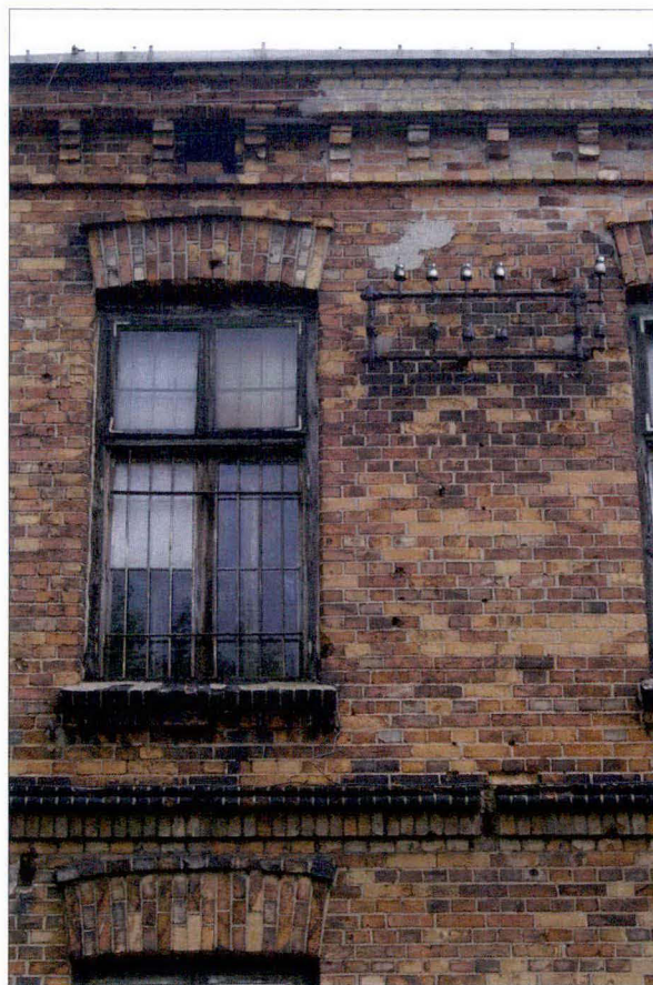
Budynek biurowy – elewacja tylna z widocznymi pozostałościami pierwotnych instalacji elektrycznych; stan na 2006 r.
