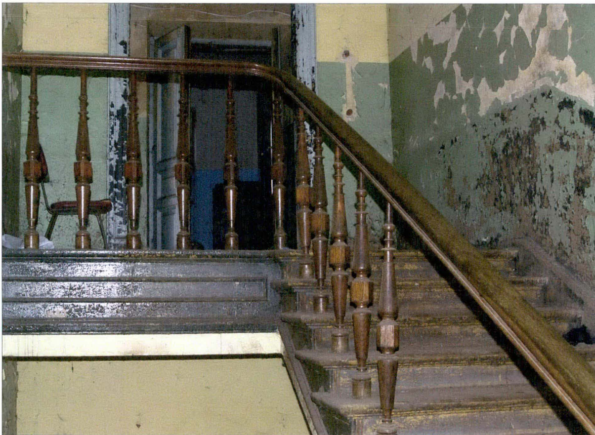
Budynek biurowy – klatka schodowa z dębowymi schodami, tralkami i poręczą; na ścianach pozostałości pierwotnej malatury; stan na 2006 r.
