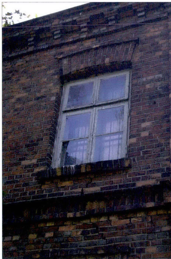
Portiernia – fragment elewacji frontowej; widoczne spękania struktury murów; stan na 2006 r.
