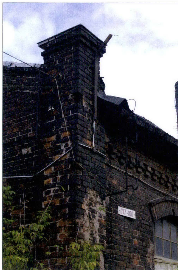
Hartownia – narożnik ściany szczytowej z pozostałościami pierwotnej instalacji elektrycznej; stan na 2006 r.
