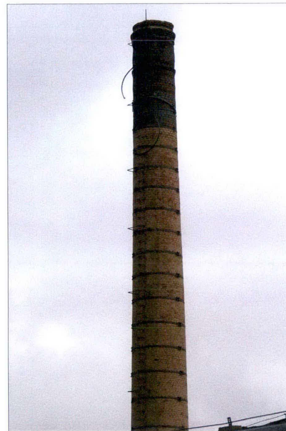
Komin fabryczny – widoczne przerdzewiałe ściągi stalowe, stan na 2006 r.
