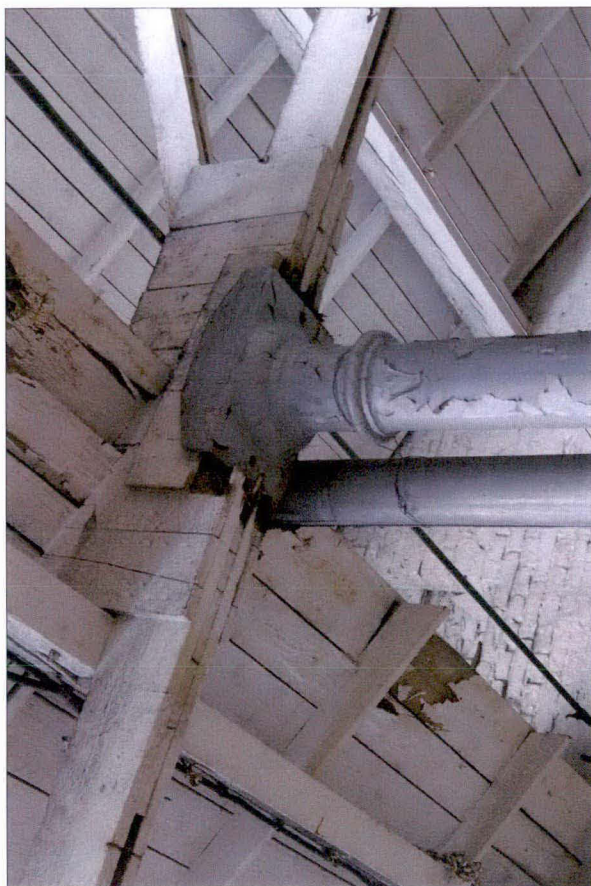
Hala główna – - gowica kolumny i węzeł dźwigarów (płatwi) dachu; stan na 2006 r.
