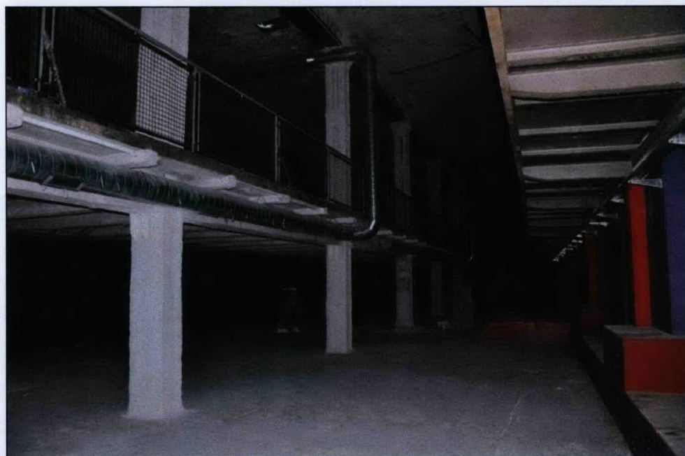
Piwnica i antresola budynku B (pierwotnie stanowiły oddzielne kondygnacje, przeprute na p. l. 70 w celu umieszczenia 2-poziomowej maszyny rotacyjnej)
