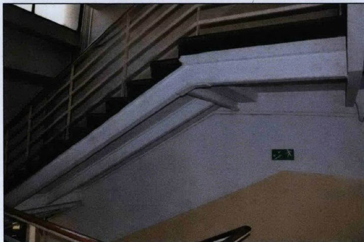
Płn. klatka schodowa, widoczna konstrukcja wsparta na dwuteownikach stalowych
