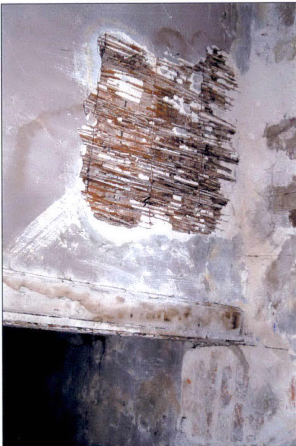
Stan zachowania drewnianego stropu w bocznej klatce schodowej. Stan na 2005 rok.
