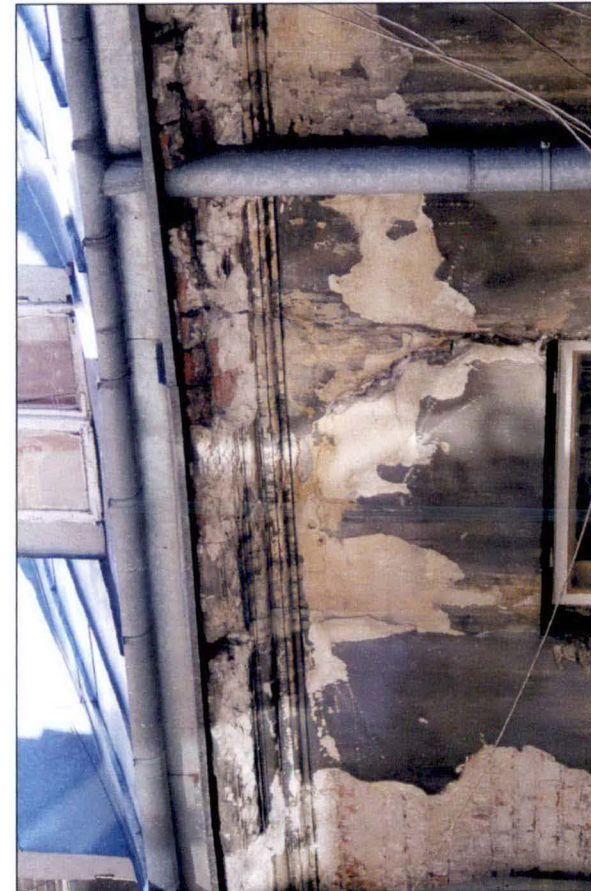
Gzyms koronujący części frontowej od podwórza. Stan na 2005 rok.
