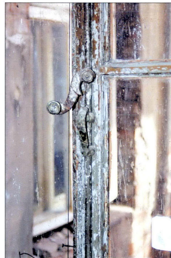
Zasuwnica w oknie bocznej klatki schodowej. Stan na 2005 rok.
