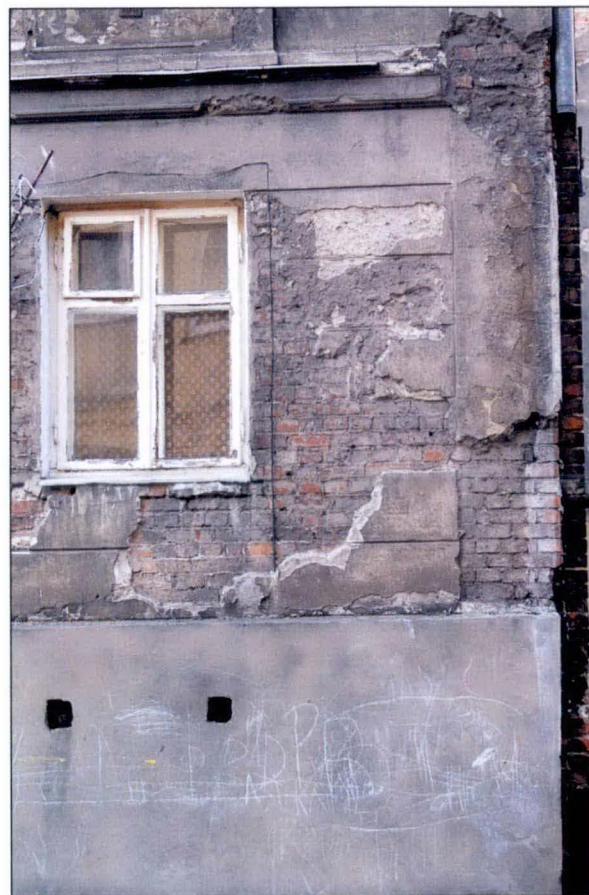
Zachowany fragment wystroju pierwszej kondygnacji. Widoczne pierwotne okno i zamurowany cokół. Stan na 2005 rok.
