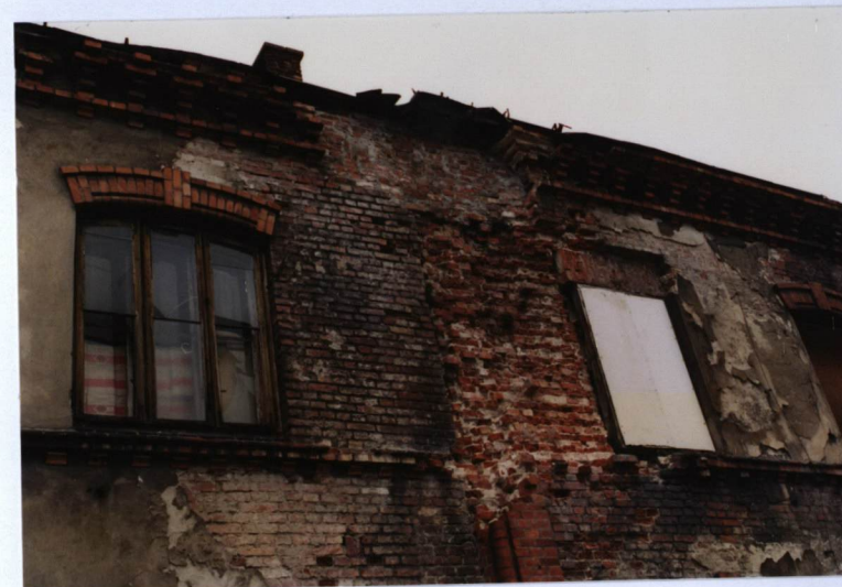
21. Zniszczenia ściany w elewacji wschodniej skrzydła pralni.
