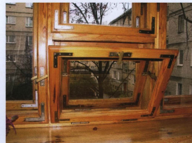
4. Lufcik w oknie trójskrzydłowym, zachowane mosiężne okucia.
