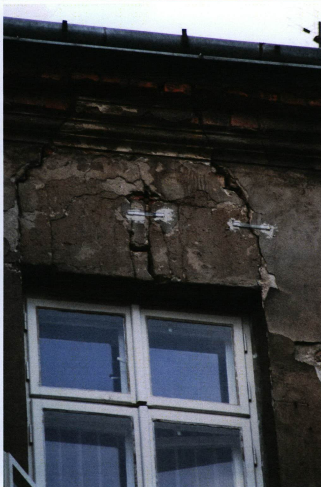
Uszkodzenia górnej kondygnacji południowej ściany części frontowej
