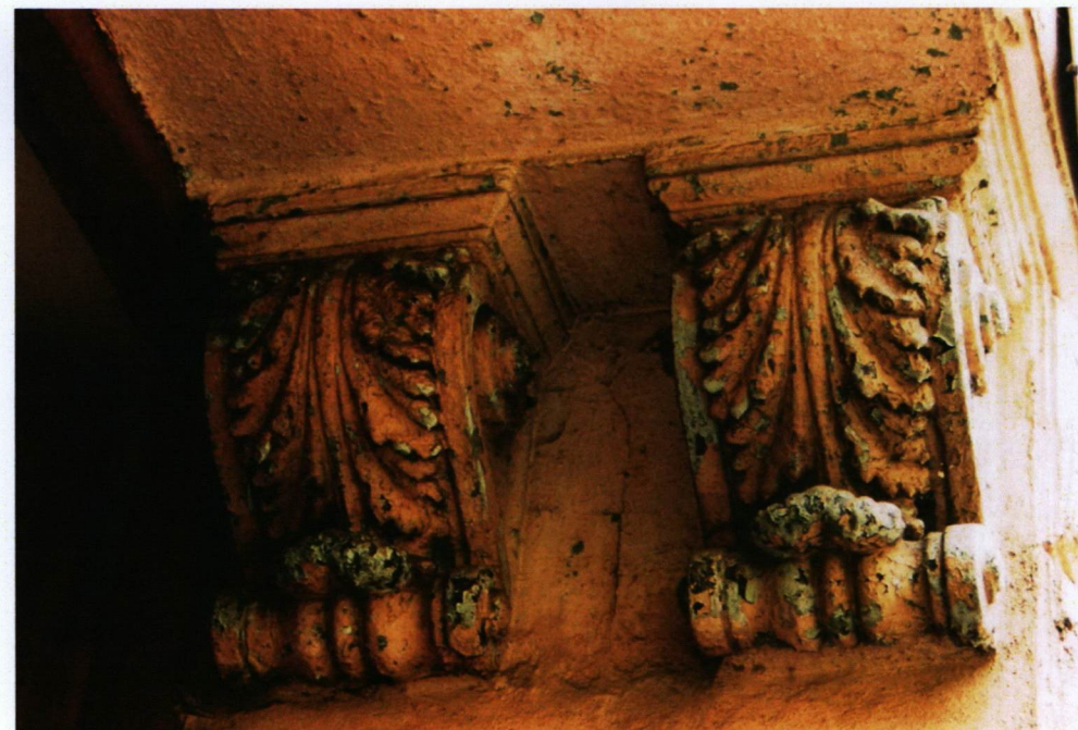
Konsole nadproża bramy frontowej
