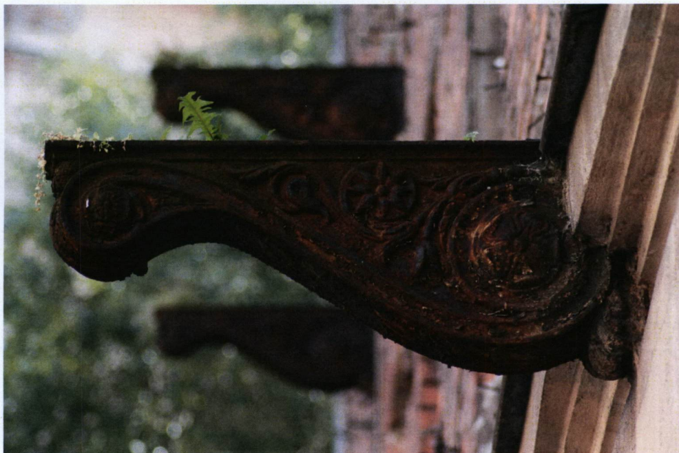
Wsporniki balkonu elewacji frontowej
