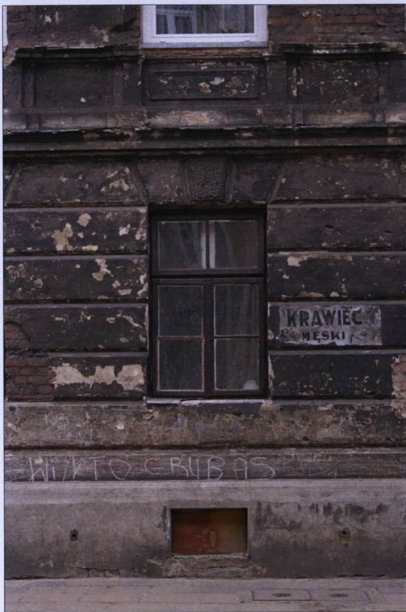
Elewacja frontowa – okno parteru; widoczne boniowanie i artykulacja gzymsu; stan na 2007 rok.
