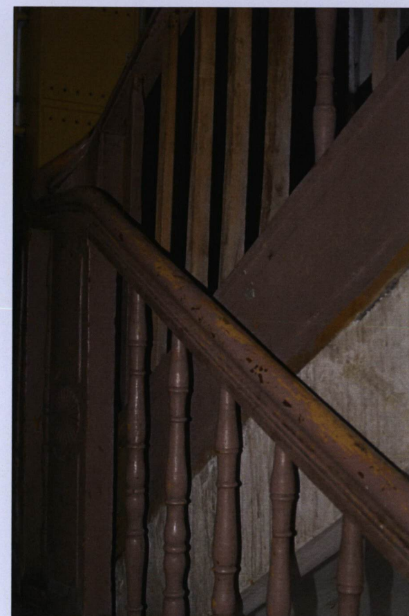
Oficina północna, klatka schodowa – balustrada; widoczne toczone tralki.
