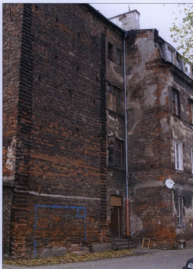
Oficyna północna – ściana szczytowa skrzydła zachodniego; widoczne strzępia w murze – relikty rozebranej oficyny tylnej; stan na 2007 rok.
