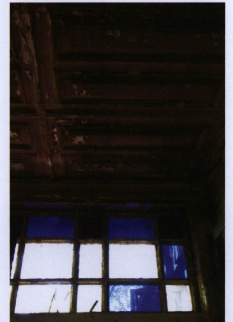
Poz. 11. Zdjęcia. Pomieszczenie ogrodu zimowego nad werandą wejścia głównego. Po lewej : Południowy narożnik ogrodu zimowego, widoczne ukośnie zamontowane narożne okno, częściowo widoczny pas wykończonego drewnianymi płycinami cokołu. W prawym górnym rogu : Zachodnia, frontowa ściana ogrodu zimowego. Pośrodku : Szklenie barwione południowej ściany ogrodu zimowego. W prawym dolnym rogu : Detal połączenia szklenia z sufitem w północnwschodnim narożniku ogrodu zimowego. Przekrój ogrodu zimowego patrz wkładka 2c.
