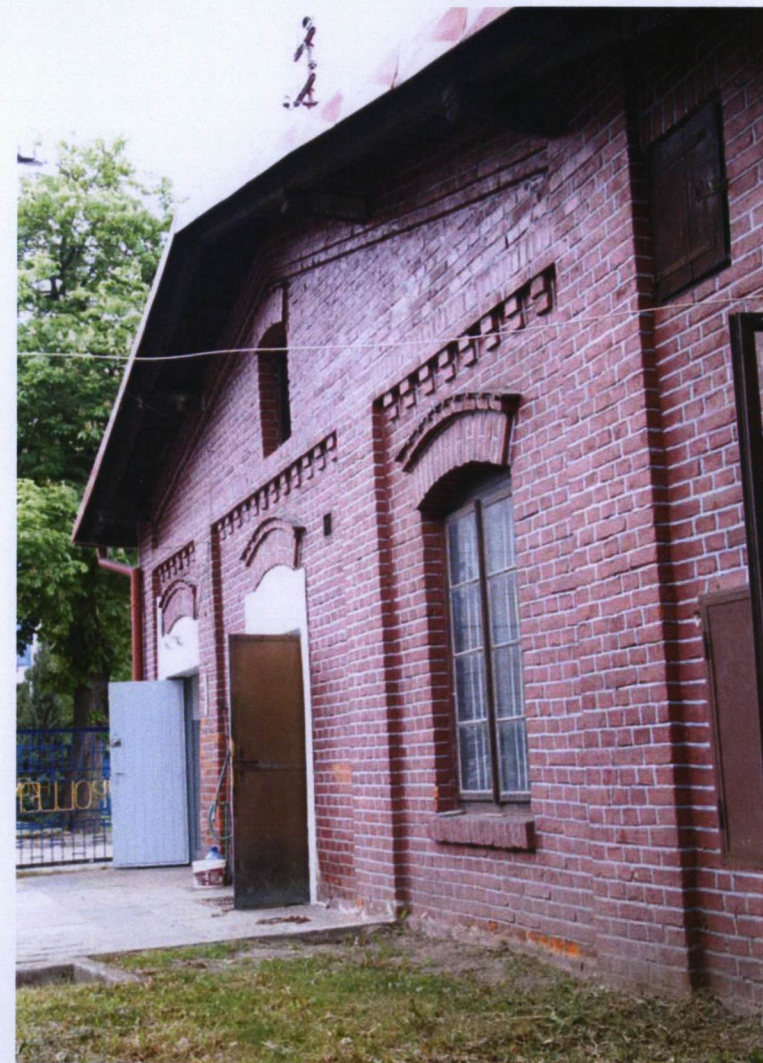
Poz. 11. Zdjęcia. Widok od wschodu na południowo-wschodnią elewację budynku, zachowany pierwotny okap z ozdobnymi zakończeniami płatwi wysuniętymi przed obrys budynku.
