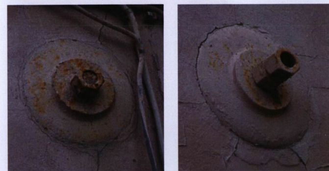
Poz. 11. Zdjęcia. U góry: Detal oprawy architektonicznej okna w zachodniej ścianie szczytowej środkowego traktu głównej części budynku. U dołu: Ściąg pierwotnego, nieistniejącego stropu na południowo-wschodniej elewacji budynku.
