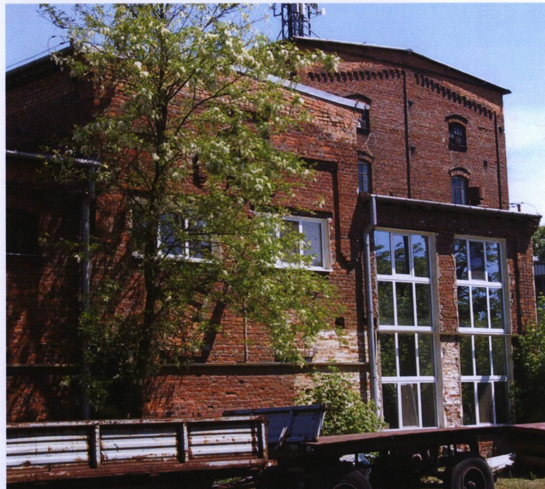
Poz. 11. Zdjęcia. Widok od północy na południowo-zachodnią część budynku, na drugim planie po prawej zachodnia elewacja dawnej drożdżowni, widoczny jednolity charakter architektury pierwotnych budynków fabryki. Dwukondygnacyjne przeszklenie widoczne z prawej strony zdjęcia ma charakter wtórny.
