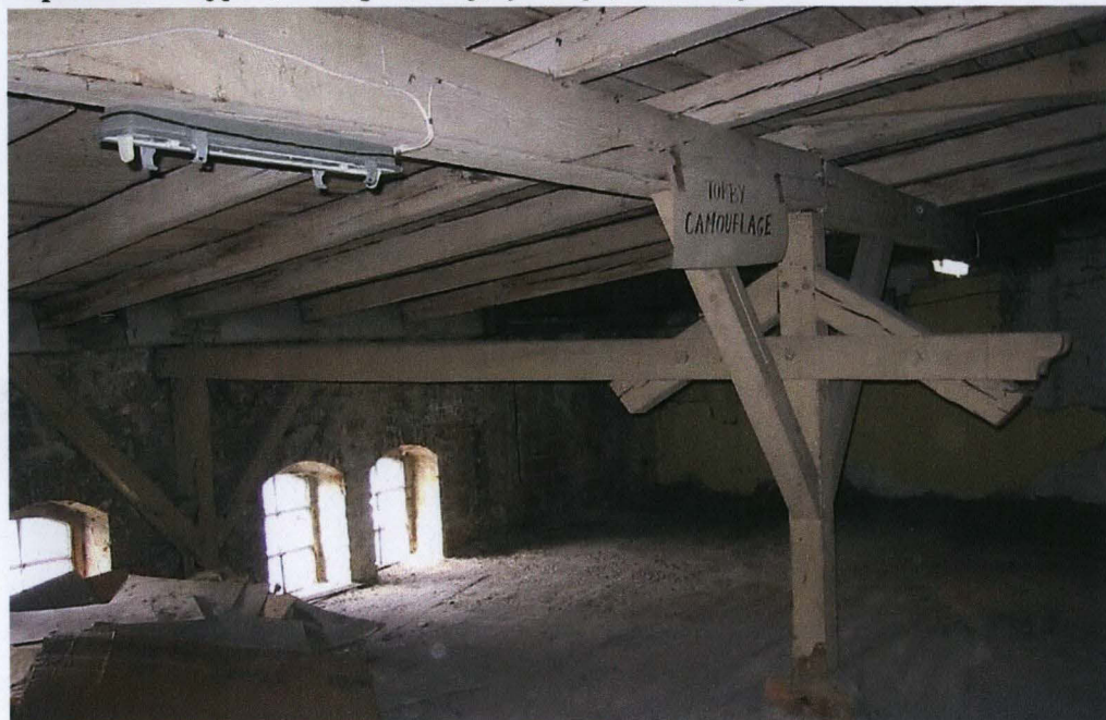
Ryc.57 Wieżba dachowa we wnętrzach poddasza.
