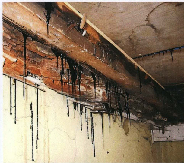
Ryc.41 Zaawansowana destrukcja drewnianych elementów więźby dachowej.
