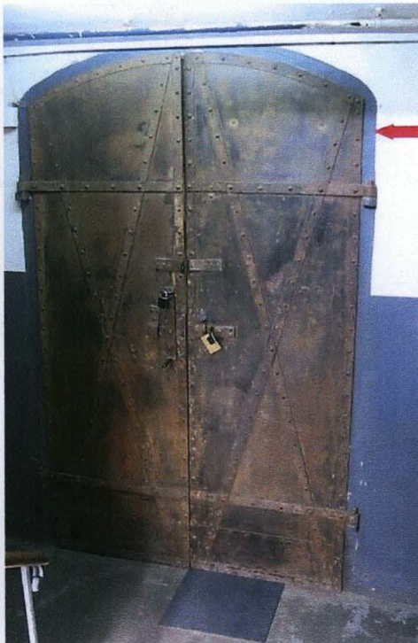
Ryc.44 Żelazne drzwi typu-1. prowadzące do piwnic.
