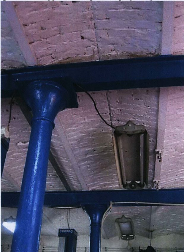
Ryc.70 Stropy odcinkowe wsparte na okrągłych słupach w zachodnim skrzydle budynku.
