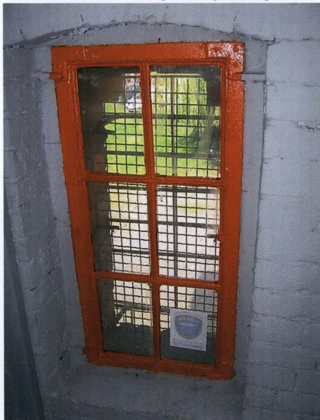
Ryc.73 Oszklony metalowy ramiak wielokwaterowy w zachodnim skrzydle budynku na piętrze.
