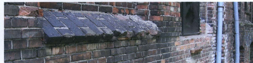
Ryc.55 Detal ceglanych parapetów na elewacji wschodniej.
