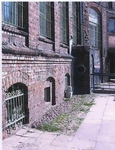
Ryc.33 Bruk kamienny wzdłuż cokołu elewacji tylnej.
