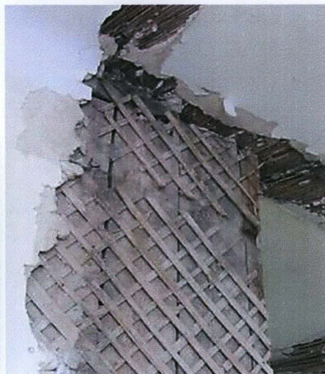
Ryc.40 Drewniana ściana działowa w czasie remontu na II piętrze.
