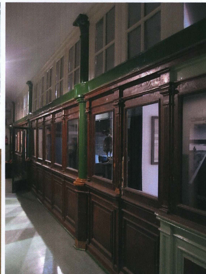
Ryc.38 Drewniane, przeszklone modułowe przepierzenie – wschodnia ściana głównego korytarza parteru.
