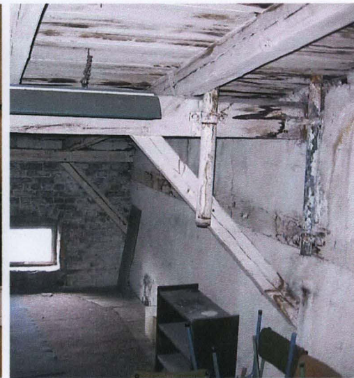
Ryc.42 Zawilgocona, zagrzybiona i pokryta pleśnią więźba dachu.
