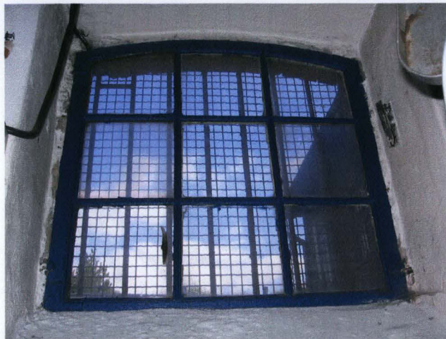
Ryc.72 Oszklony metalowy ramiak wielokwaterowy w zachodnim skrzydle budynku na parterze.
