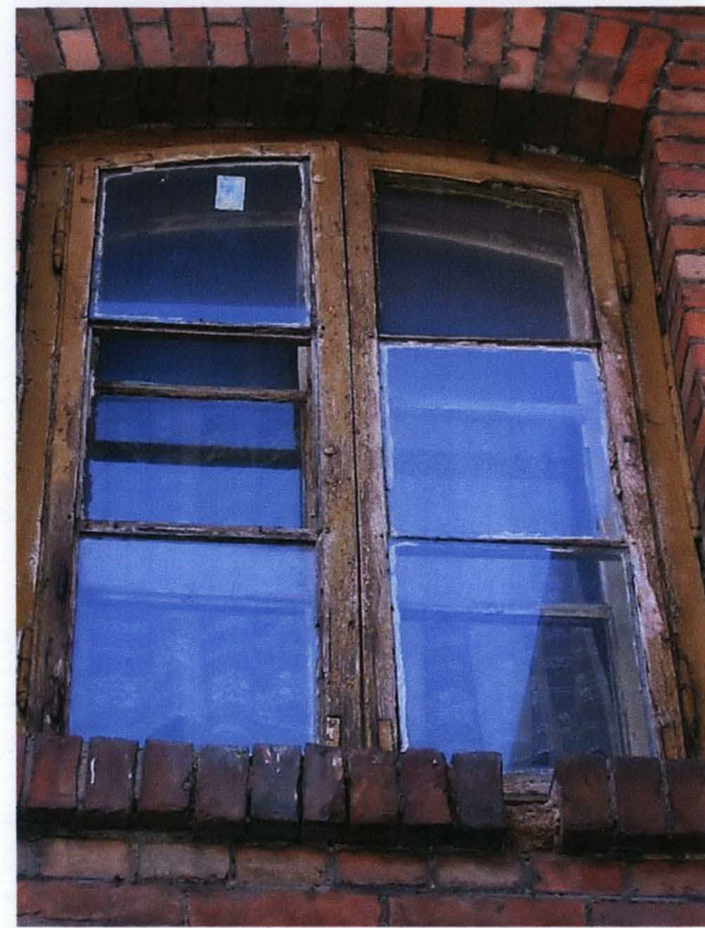
Ryc.74 Drewniane okno ościeżnicowe na I piętrze elewacji frontowej budynku.
