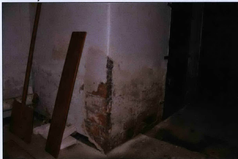
nr 19 Fundamenty (widoczne zawilgocenie)
