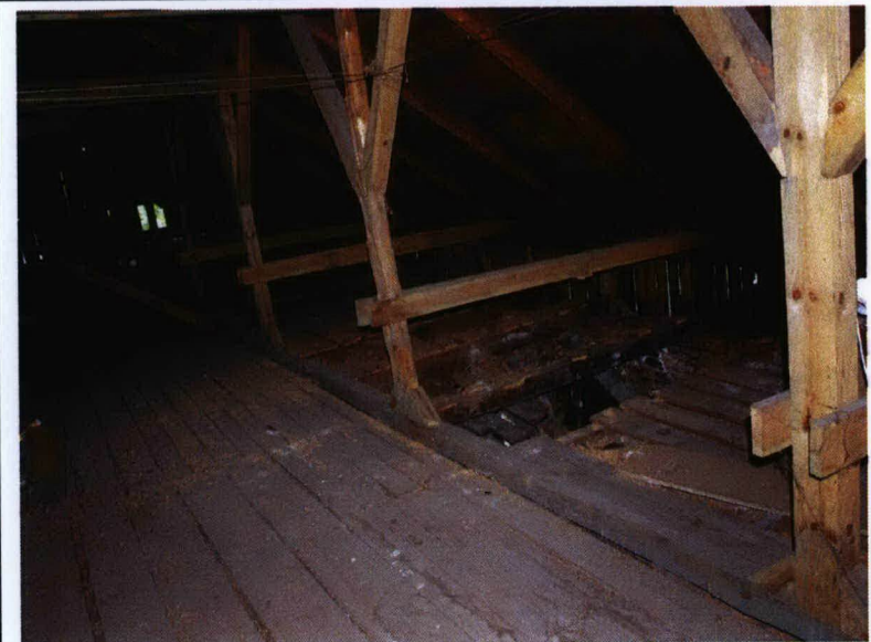
33. Wieżba dachowa i ślad po pożarze.
