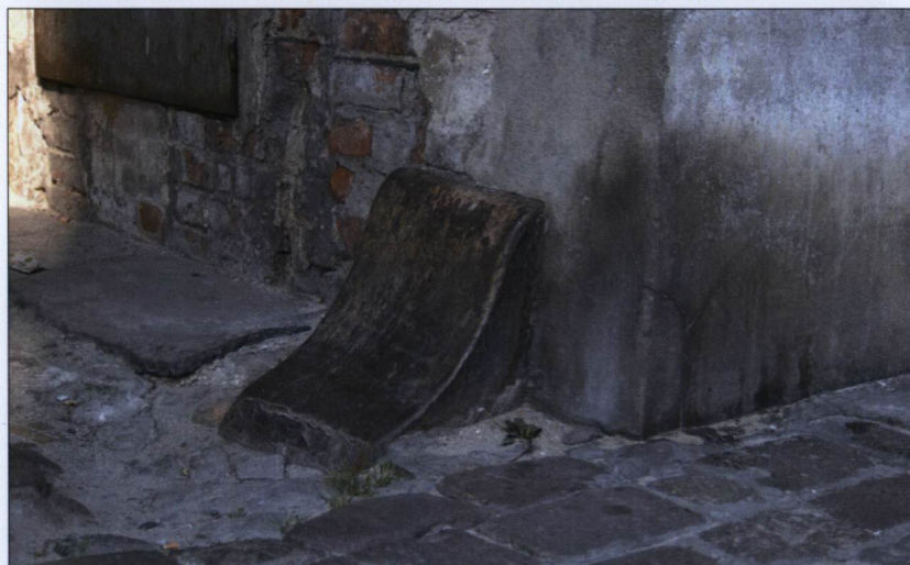
Elewacja frontowa – odbojnik przy wjeździe na podwórze.
