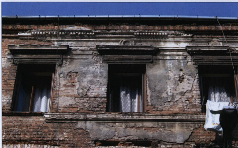
Elewacja frontowa – relikty pierwotnego wystroju sztukatorskiego.
