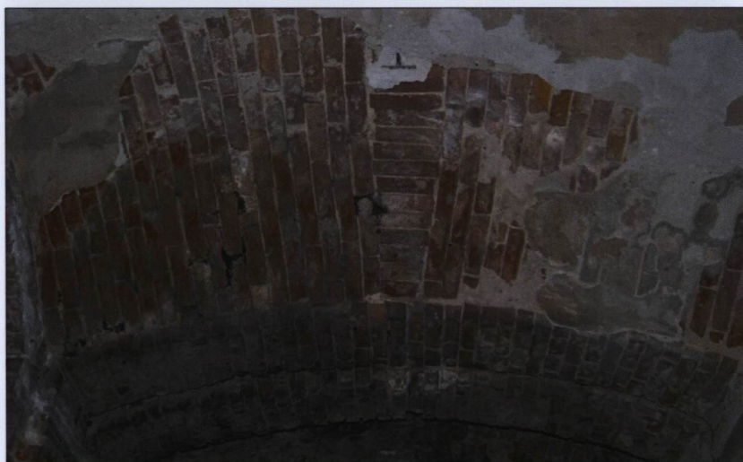
Przejazd bramny – stan zachowania sklepienia.
