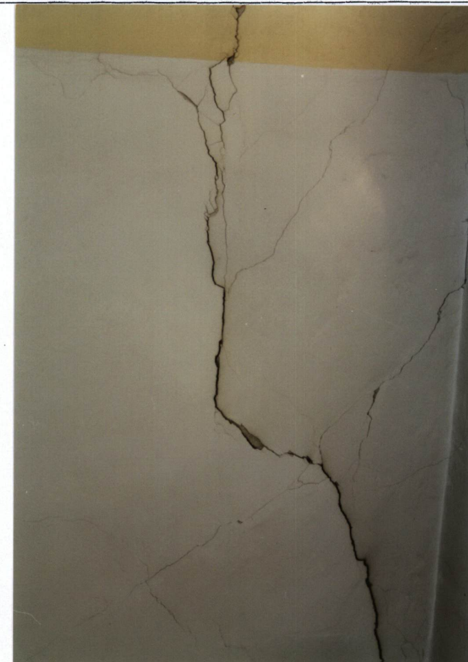
Spękania muru od strony wewnętrznej
