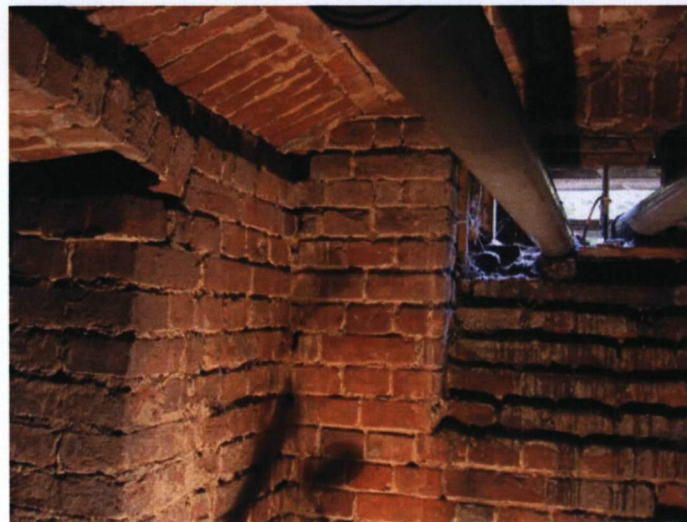
Ryc.18 Przykład rozwiązania instalacji kanalizacyjnej (stan z września 2005 r., fot. P. Kordek)
