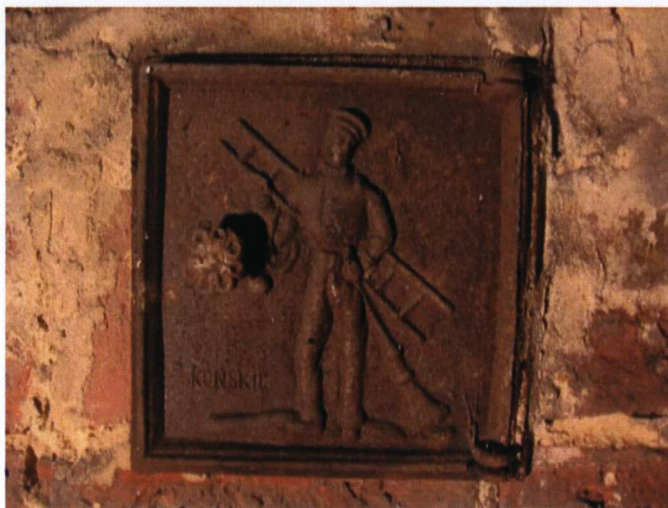
Ryc.27 Ozdobne drzwiczki rewizji przewodu kominowego (stan z września 2005 r., fot. P. Kordek)
