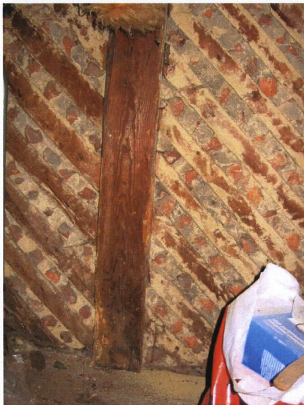
Ryc.25 Konstrukcja ściany na poddaszu (stan z września 2005 r., fot. P. Kordek)
