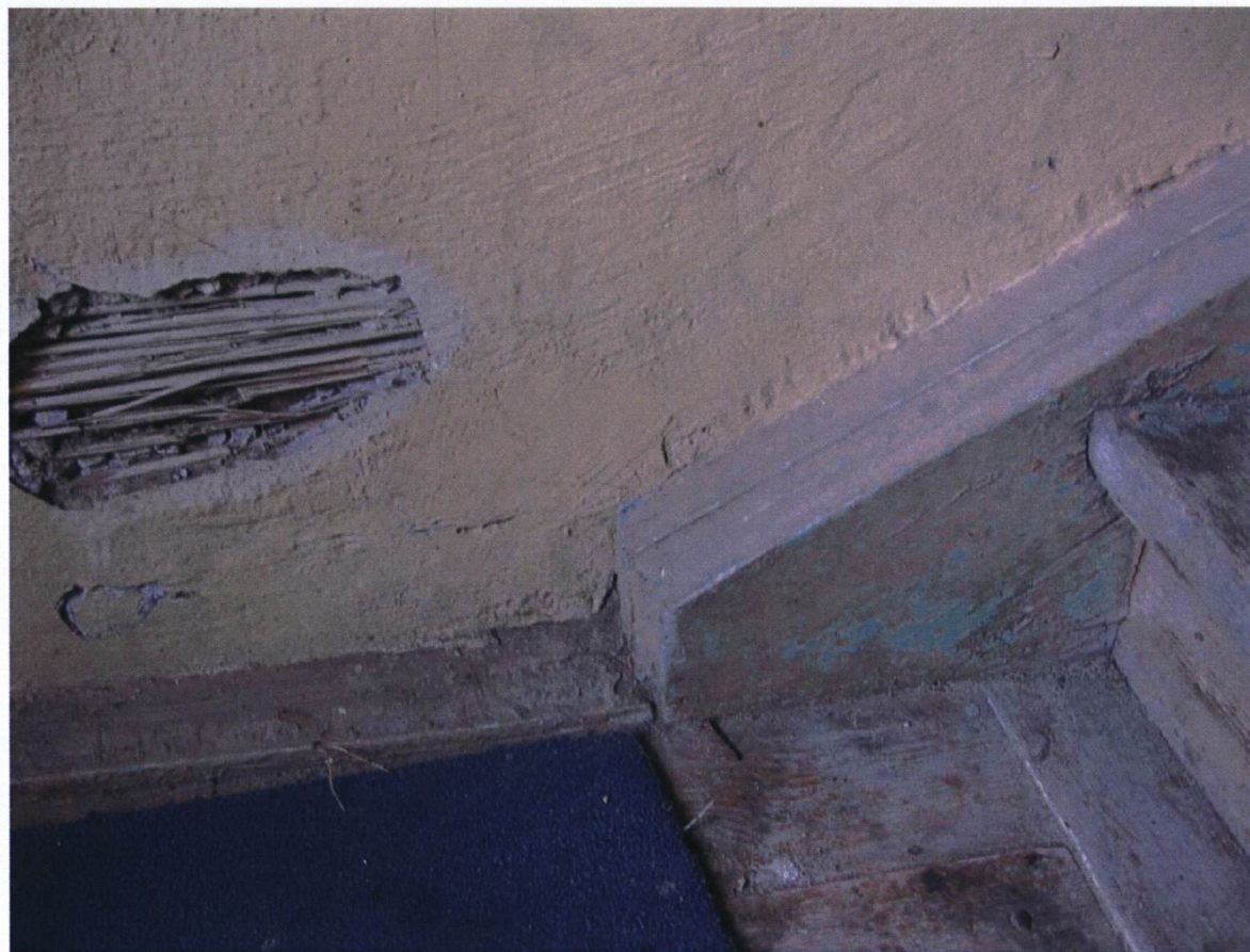
Ryc.26 Trzcinowe podłoże tynku (odkrywka) (stan z września 2005 r., fot. P. Kordek)
