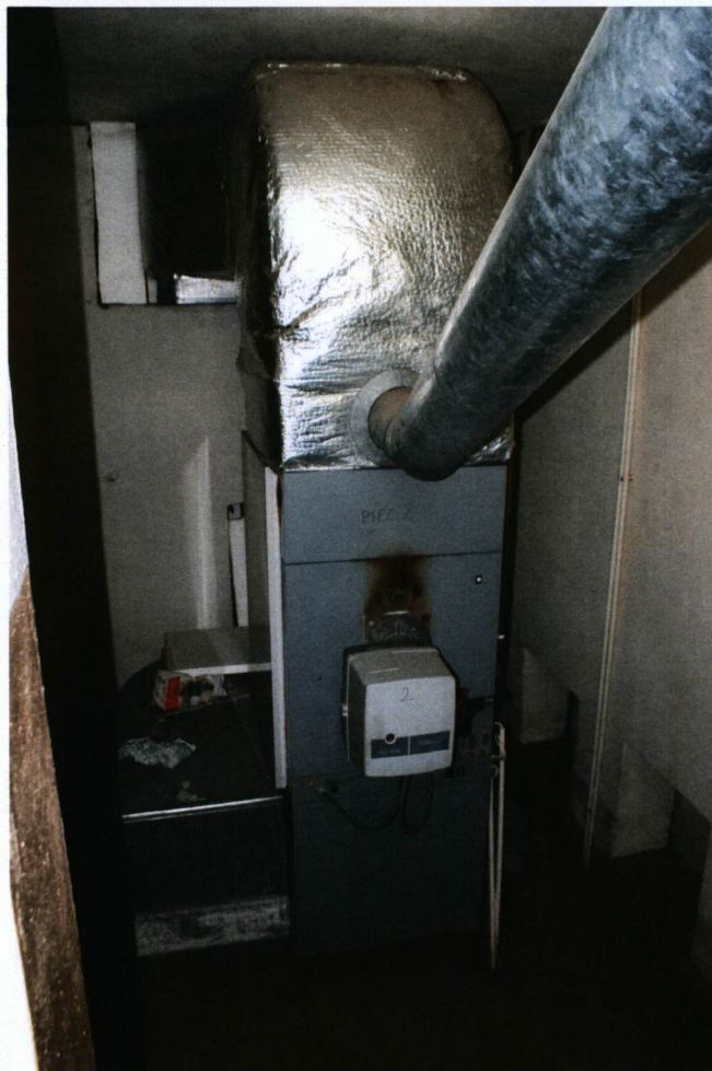
Piwnica pod zakrystią, jeden z dwóch pieców ogrzewających kościół
