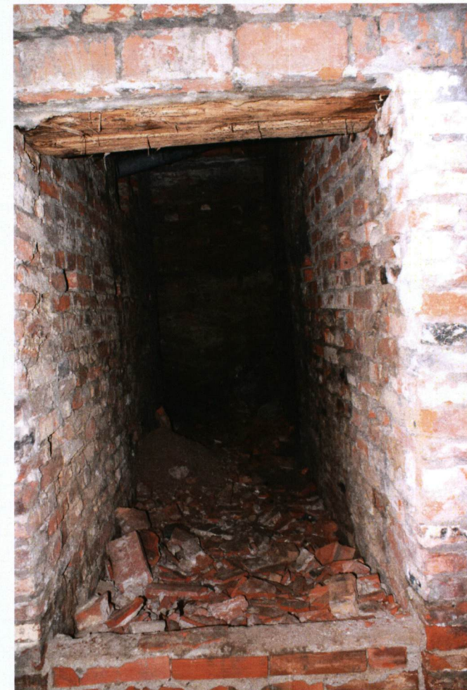
Piwnica pod północnym traktem korpusu, przebite przejście do pomieszczeń zasypanych w 1944 r.
