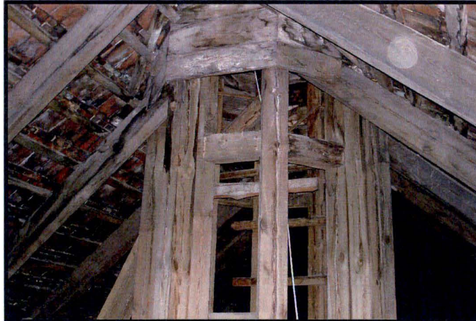
Fot. 65 Konstrukcja wieżba pod sygnaturką, Stan 3.XI.2006 r.
