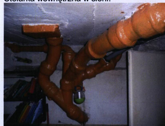
Strop żelbetowy w piwnicy i kanalizacja.
