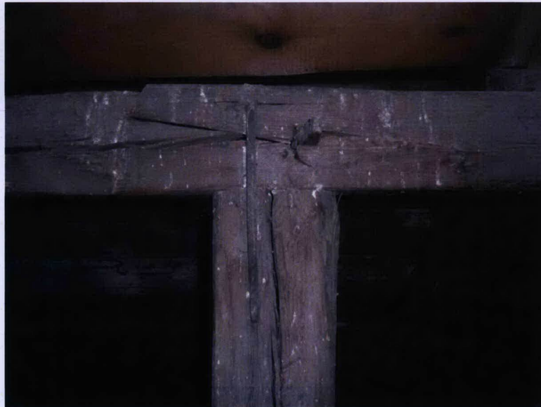
Więźba krokwiowo-jętkowa dwustolcowa – elementy wtórnie użyte (?), detal złącza wzdłużnego płatwi.
