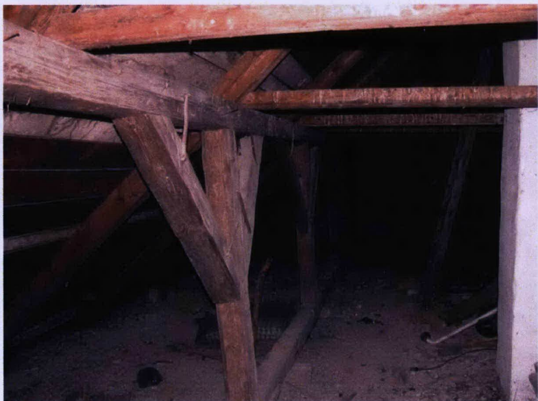
Więźba krokwiowo-jętkowa dwustolcowa – elementy wtórnie użyte (?), detal złącza wzdłużnego płatwi.
