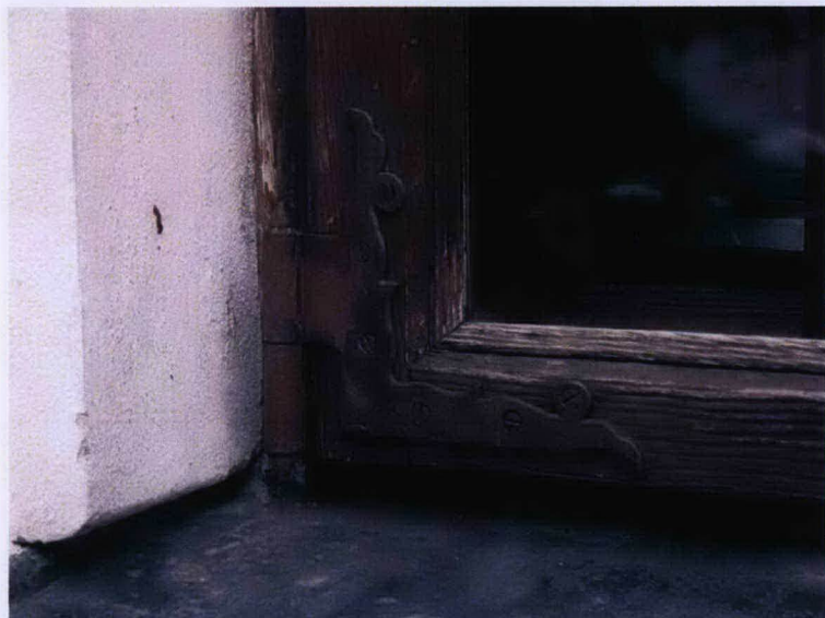
Detal okucia okna zewnętrznego.
