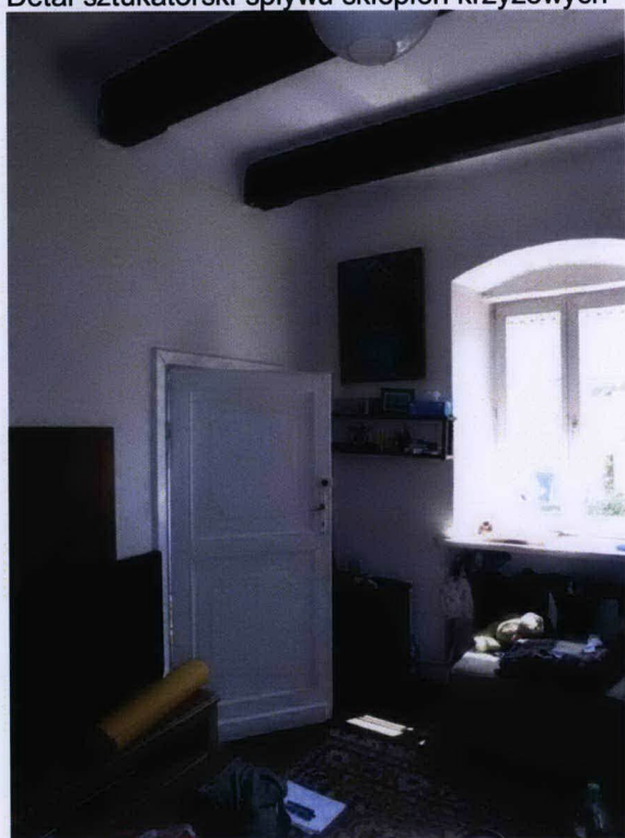
Wnętrza celi – pom. nr 2 i drewnutni – pom. nr 4 – ze stropami na drewnianych belkach.
