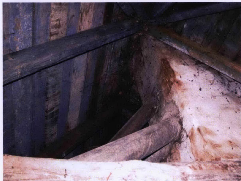
Krokwie – w miejscu zejścia 3 połaci dachu.
