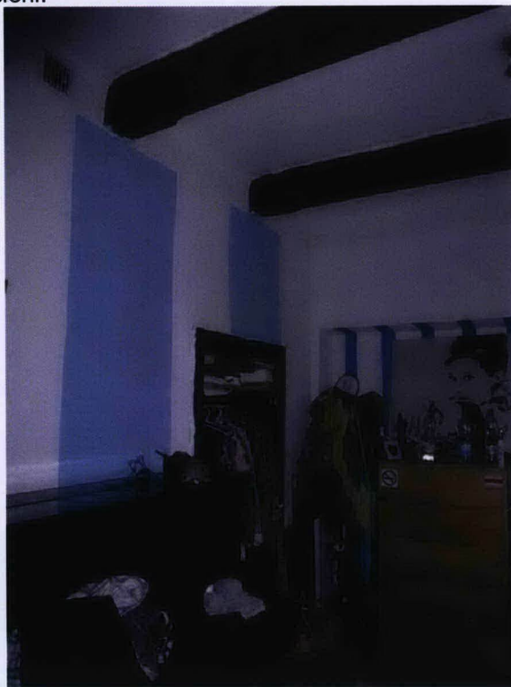
Wnętrza celi – pom. nr 2 i drewnutni – pom. nr 4 – ze stropami na drewnianych belkach.
