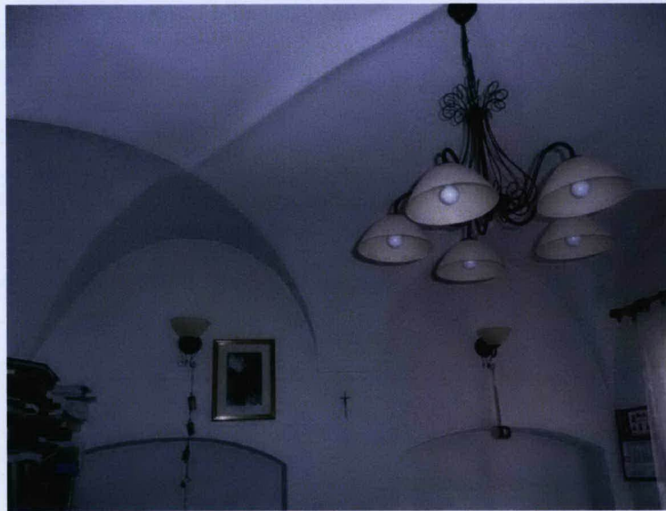
Sklepienie klasztorne z lunetami w drewutni – pom. nr 4 i kolebka z przęsłem krzyżowym w kaplicy.
