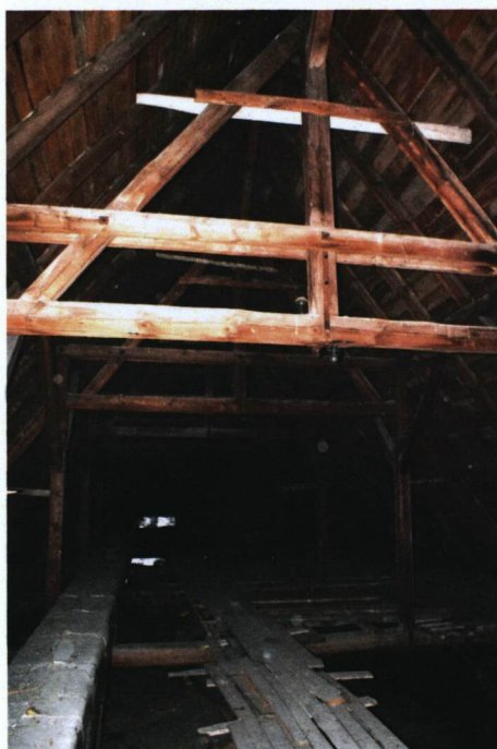
Więżba nad nawą główną, widoczne kanały nawiewne systemu oarczewania kościoła
