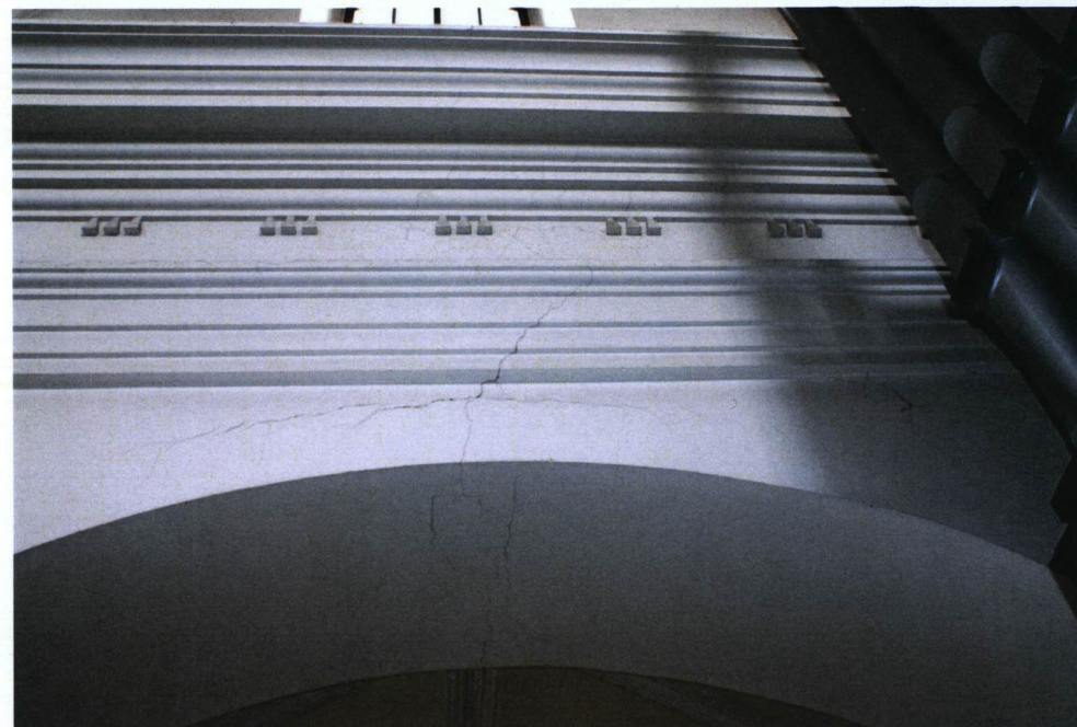
Spękania łuku arkady zachodniego przęsła nawy południowej
