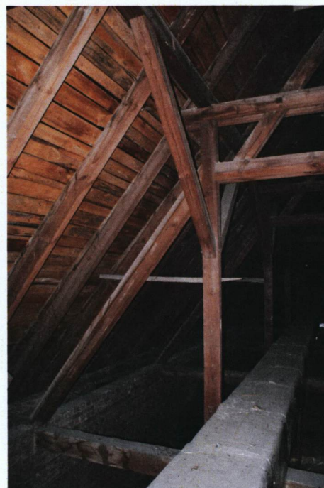
Więżba nad nawą główną, widoczne kanały nawiewne systemu oarczewania kościoła
