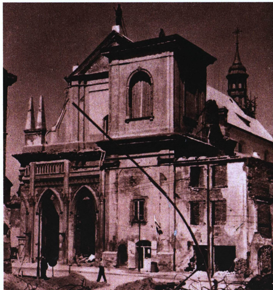
Odbudowa kościoła, widoczny odtworzony dach nawy głównej z sygnaturką, fragment wyburzanej galerii neogotyckiej 1950
