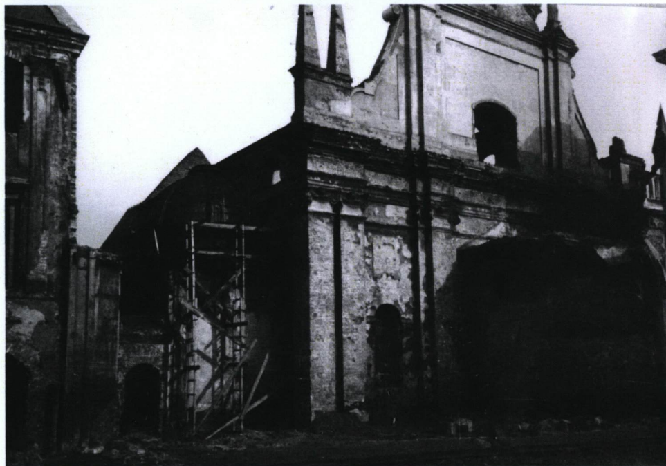
Odbudowa kościoła, odtworzona konstrukcja kopuły kaplicy Kotowskich. wyburzona część neogotyckiej galerii 1949
