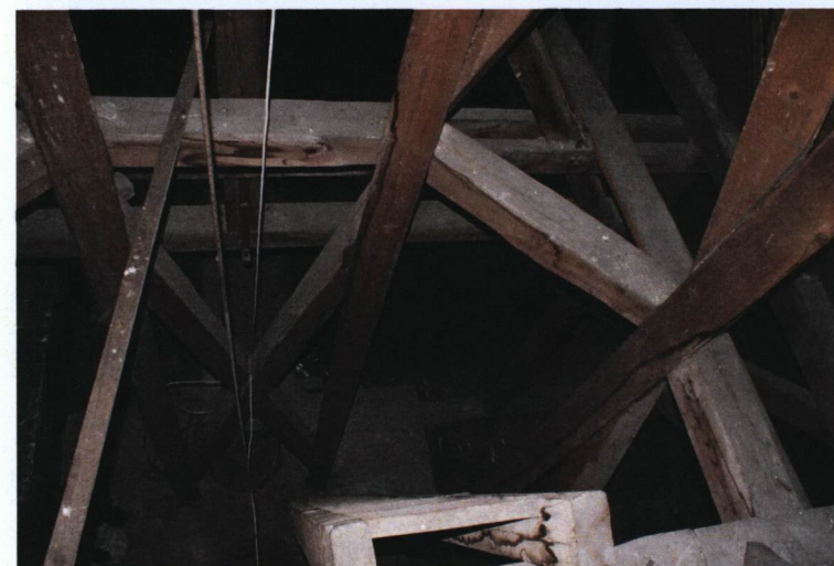
Konstrukcja nośna sygnaturki nad nawą główną
