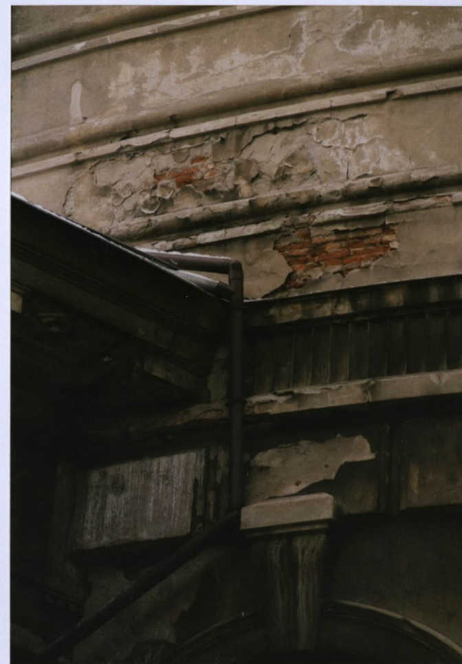
Uszkodzenia elewacji z prawej strony portyku głównego
