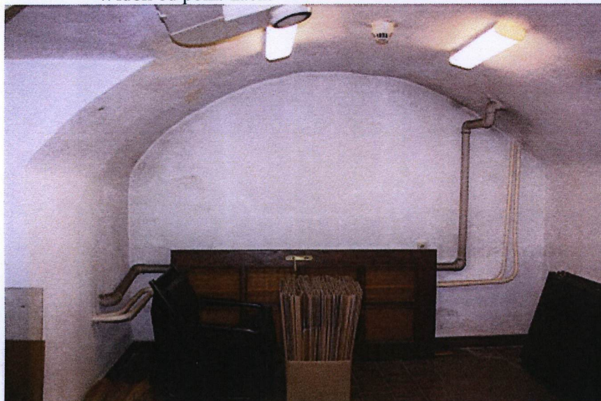
Piwnica – sklepienie kolebkowe w komorze
