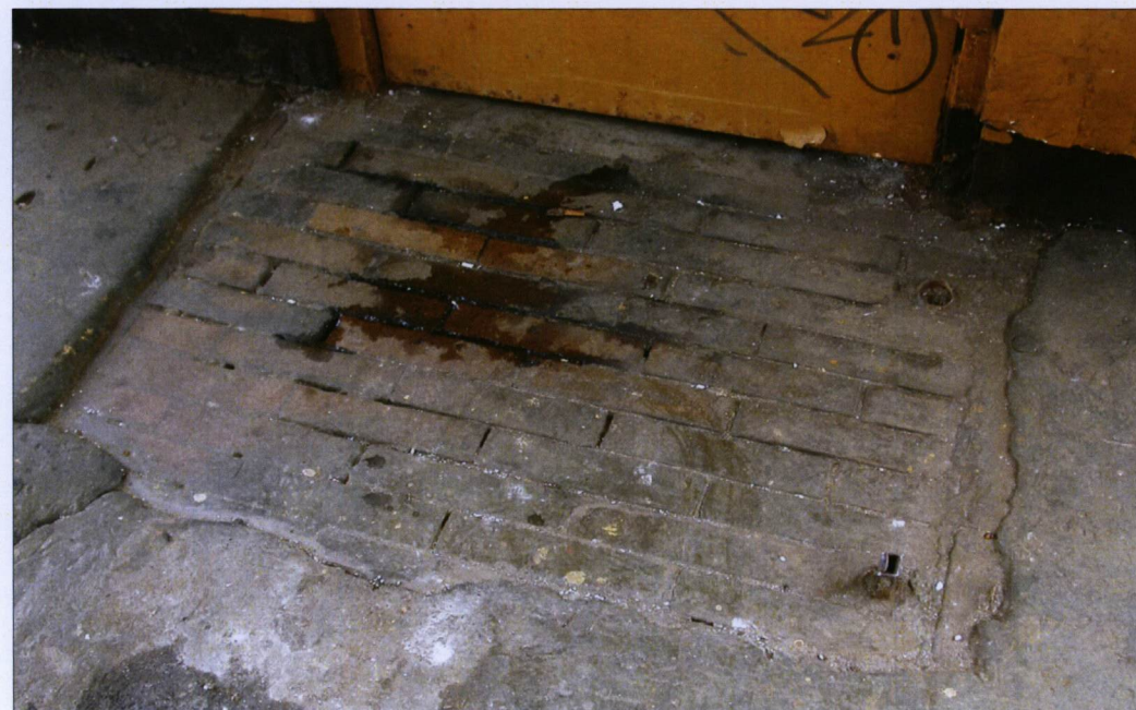
Wejście do pomieszczenia kasjera wyłożone ceglami klinkierowymi.
