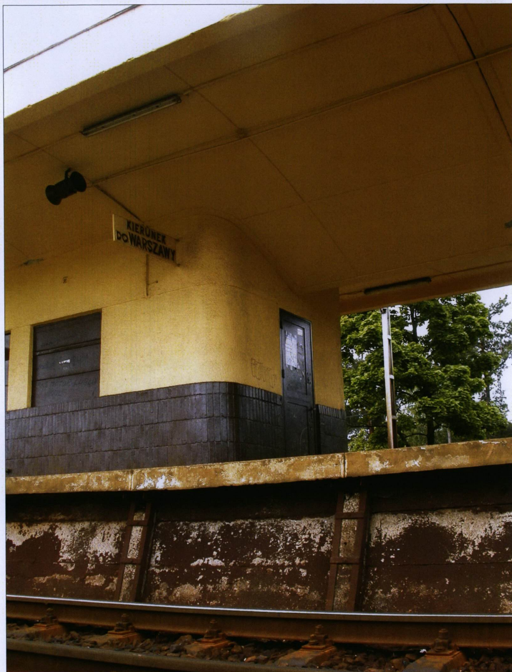
Widok z poziomu torów na prefabrykowaną krawędź peronu oraz fragment kasy biletowej.
