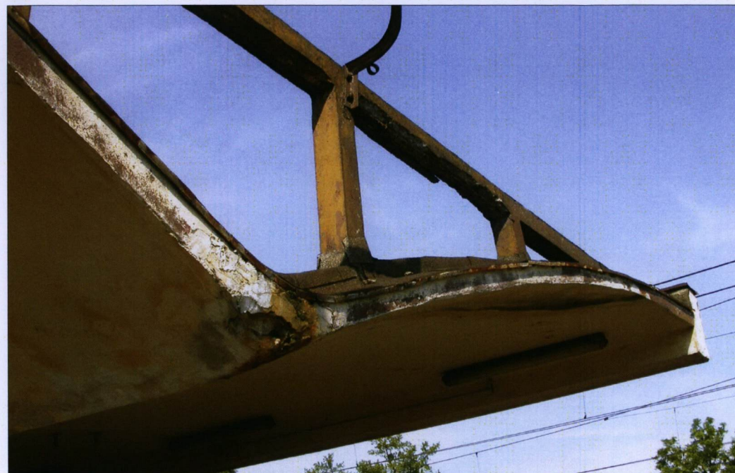
Widok czoła wiaty od strony wschodniej – brak wypełnienia.
