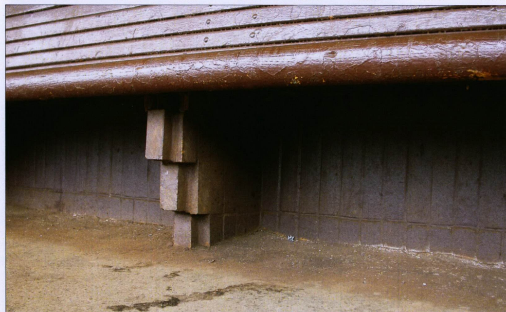
Oryginalna ławka peronowa – wspornik z cegieł.
