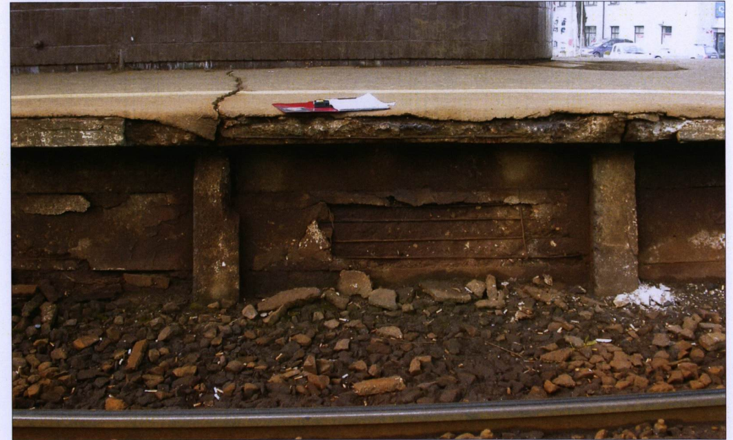
Przystanek osobowy Warszawa Międzyzlesie – widok prefabrykowanej ścianki peronu.
