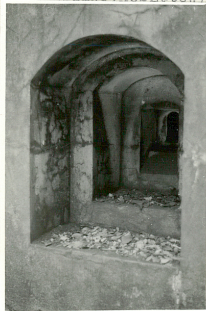
Strzelnica o profilu przeciwwykoszetowym
