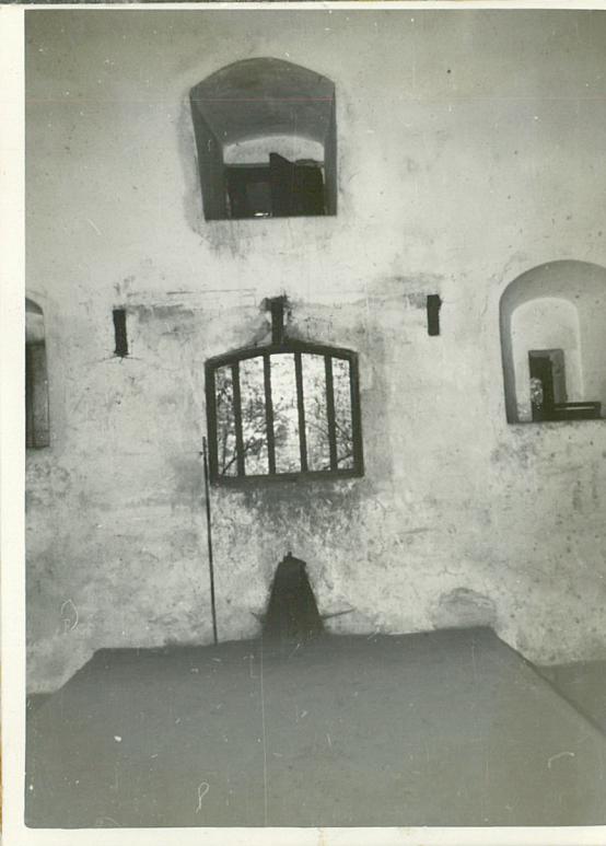
Fot.8 Wnętrze kojca pojedynczego. Widoczna strzelnica działowa z podstawą pod działą, nad nią otwór wentylacyjny, po bokach strzelnice dla broni ręcznej
