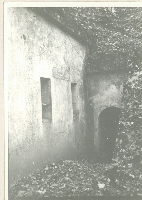
Fot.10 Wejście do kojca od strony przeciwstoku widoczne strzelnice dla broni ręcznej
