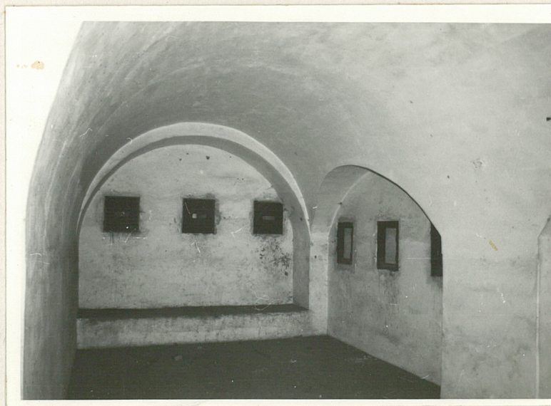
Fot. 4 Nowe otwory strzelnicze przeciwykoszetowe.
