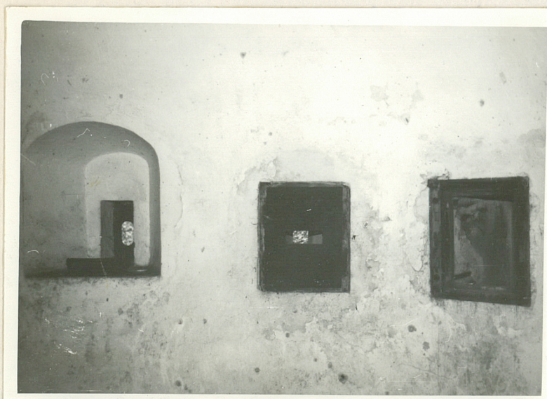
Fot.6 Zachowane fragmenty stolarki strzelnic. Widoczne zniszczone stalowe tarcze okienne
