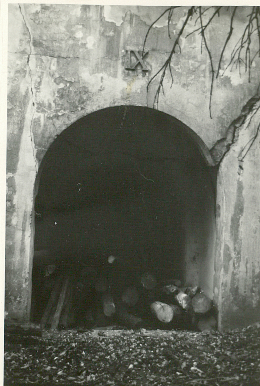
Fot.2 Pęknięte lico ściany
