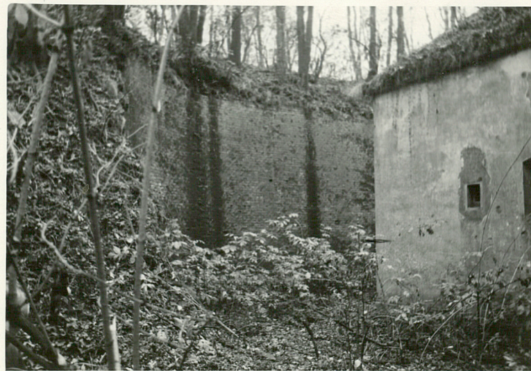
Fot.18 Niszczenie przeciwstoku powodowane roślinnością.
