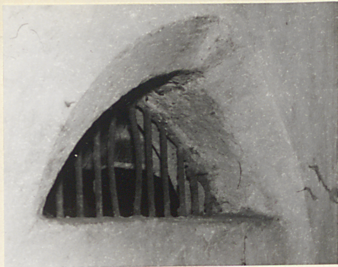
górna część zamurowanego portalu z kratą w komorze piwnicznej w trak- cie tylnym d. budynku wsch.
