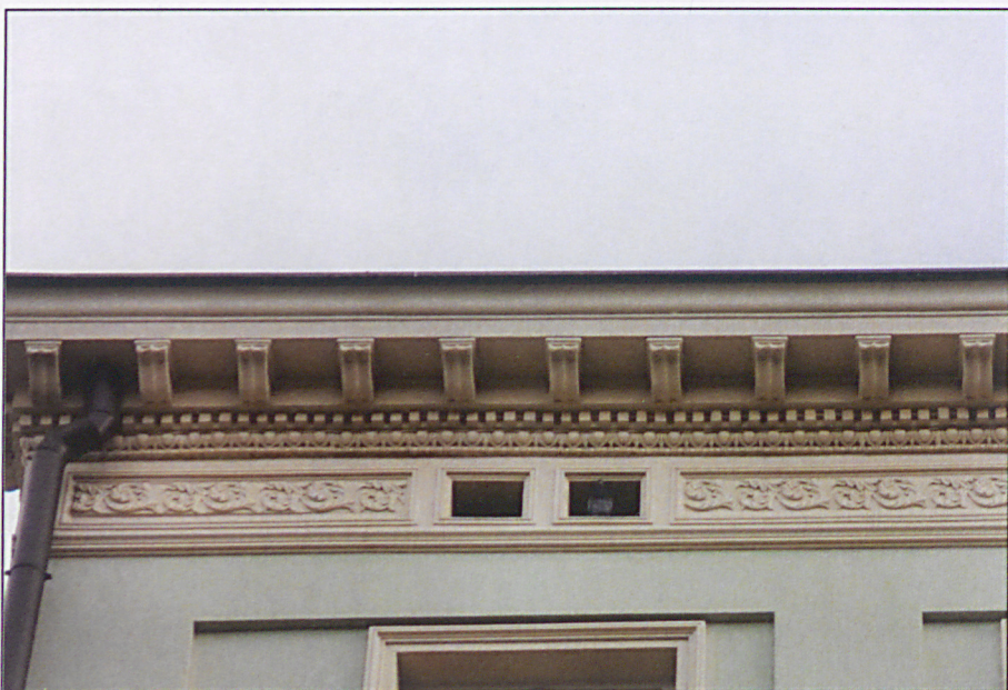
Detal gzymsu okapowego
