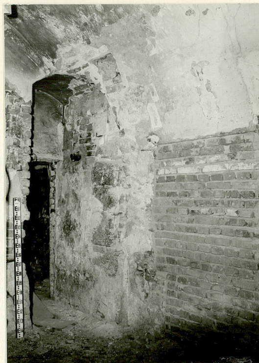
Pn.-zach. narożnik komory piwnicznej w pd. części traktu frontowego; widoczny glif wyjścia z regularnych ciosów wapiennych
