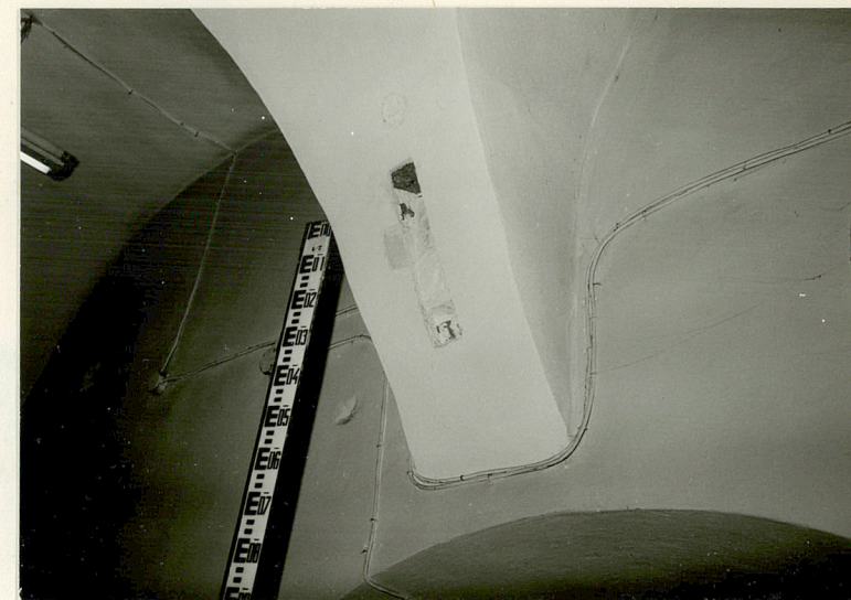
fragment sklepienia nad помещением w pd. części traktu frontowego parteru /d. sklep/; widoczny odsłonięty częściowo kroksztyn gotyckiego arkadowania
