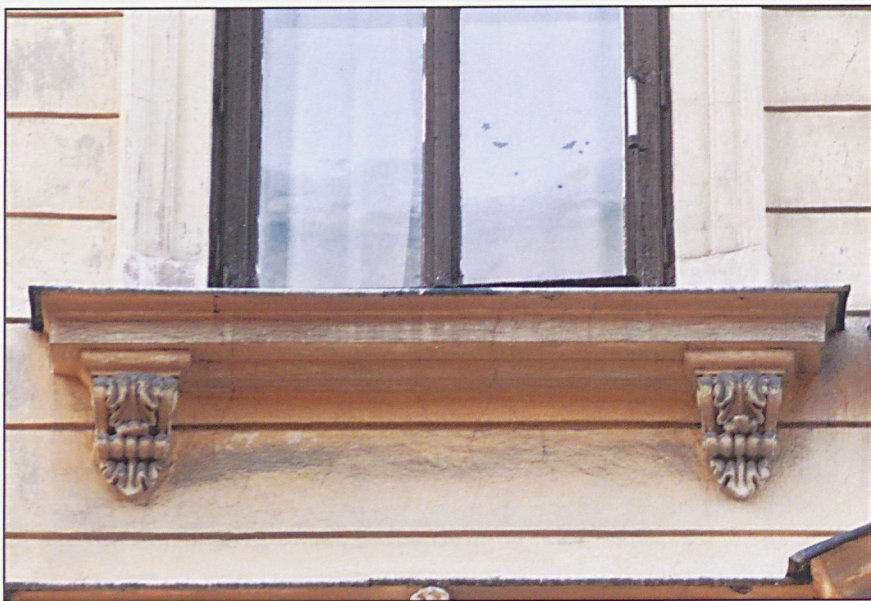
Detal okna osi środkowej 2 piętra – parapet na konsolach
