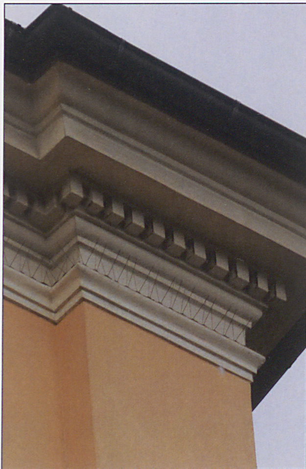
Detal gzymsu podokapowego
