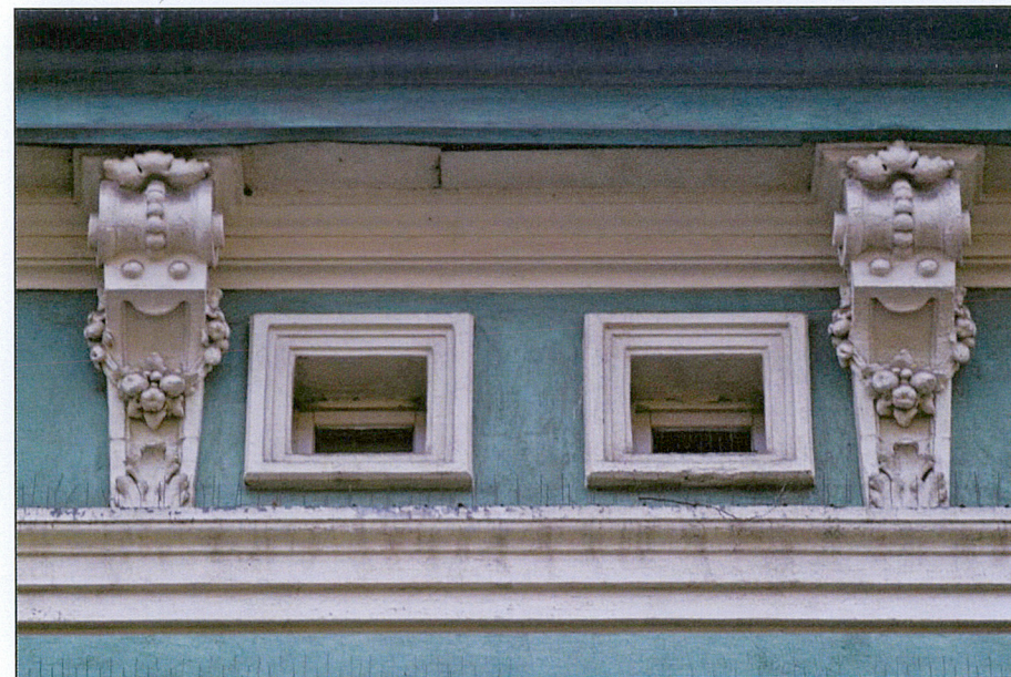
Detal okienek strychowych i gzymsu podokapowego
