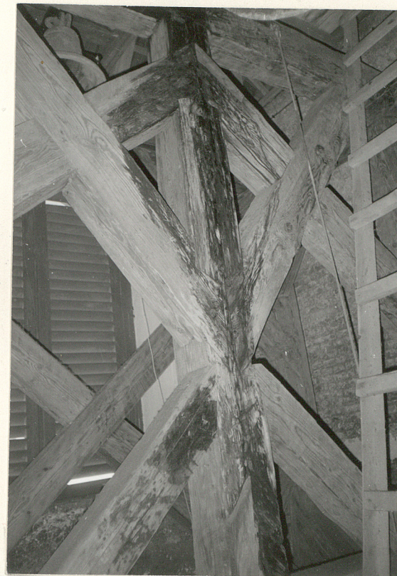
fragment konstrukcji nośnej dzwonów
