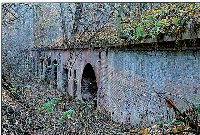
16. Widok ogólny, widoczny brak ścian elewacyjnych kazamat.
