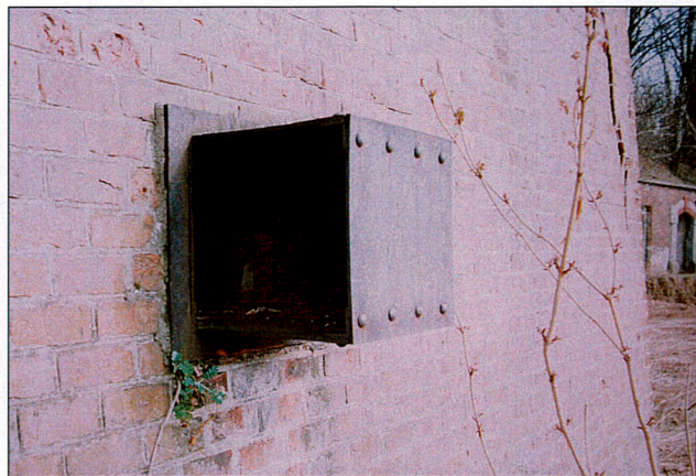
10. Pancerna osłona reflektora na elewacji lewego skrzydła koszar.
