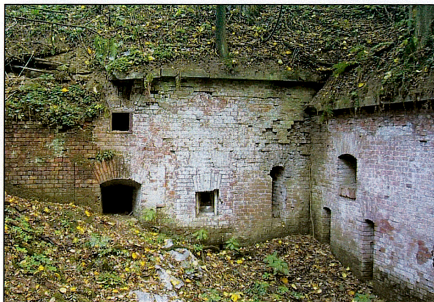
29. Kaponiera lewego barku. Widoczny stopień zasypania ziemią i zawilgocenia.
