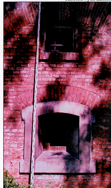
7. Charakterystyczne obramienie otworów strzelnic.
