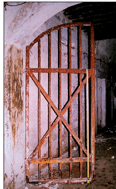
27. Drzwi z kraty fortecznej do kaponiere czołowej
